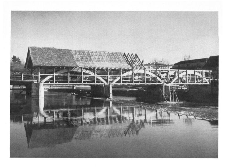
Bremgarten. In genau derselben Form und unter Verwendung der alten Bauteile, doch verbreitert, ist die Holzbrücke wieder aufgebaut worden und vermag nunmehr wieder allen Ansprüchen zu genügen.
