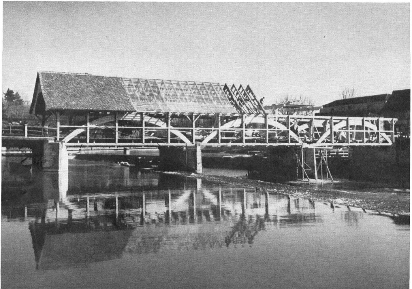
*Bremgarten. In genau derselben Form und unter Verwendung der alten Bauteile, doch verbreitert, ist die Holzbrücke wieder aufgebaut worden und vermag nunmehr wieder allen Ansprüchen zu genügen.*
