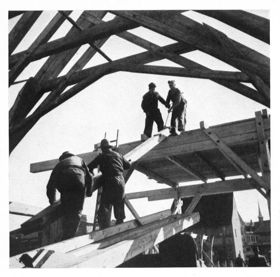
Alle Balken für die neue Reußbrücke waren vorher genau zugeschnitten und numeriert worden, so daß sich der Aufbau in kürzester Zeit durchführen ließ.
