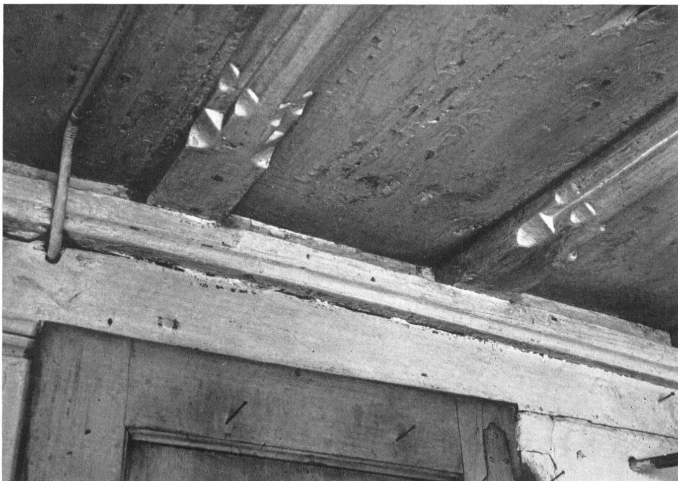
Die Stube im Hause zu Reudlen (s. S. 46) hat als besonderen Schmuck noch die flachgewölbte spätgotische Balkendecke.
