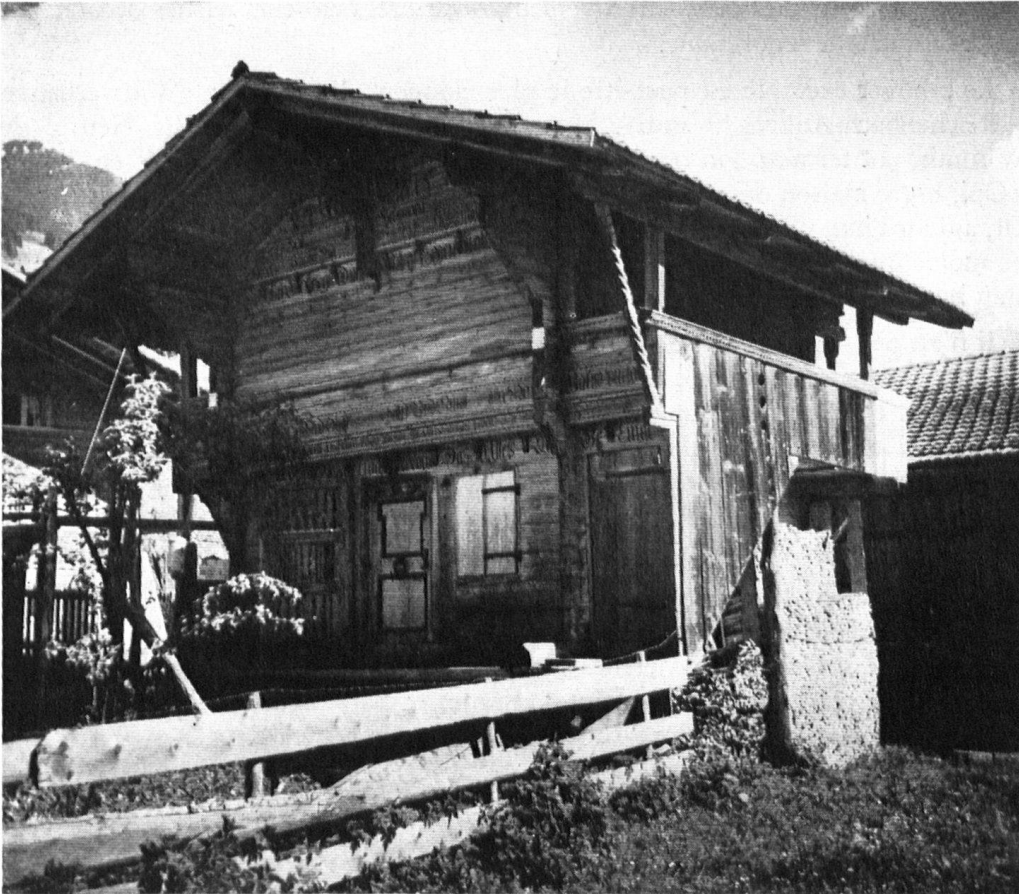
Speicher in Reichenbach, der demnächst mit Hilfe des Berner Heimatschutzes erneuert werden soll. Man beachte die schöne Doppeltüre. Das obere Bild zeigt die innere, das untere die äußere Türe.
