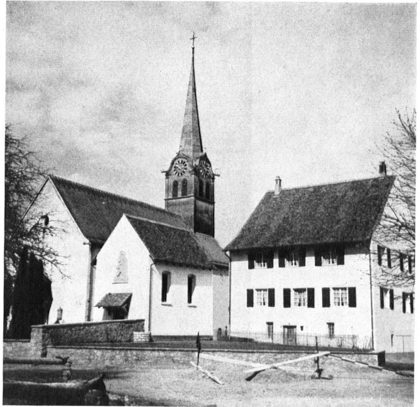
Kapelle und Pfarrhaus Göslikon im Aargau sind unter Aufsicht des Aargauer Heimatschutzes trefflich instand gestellt worden.
