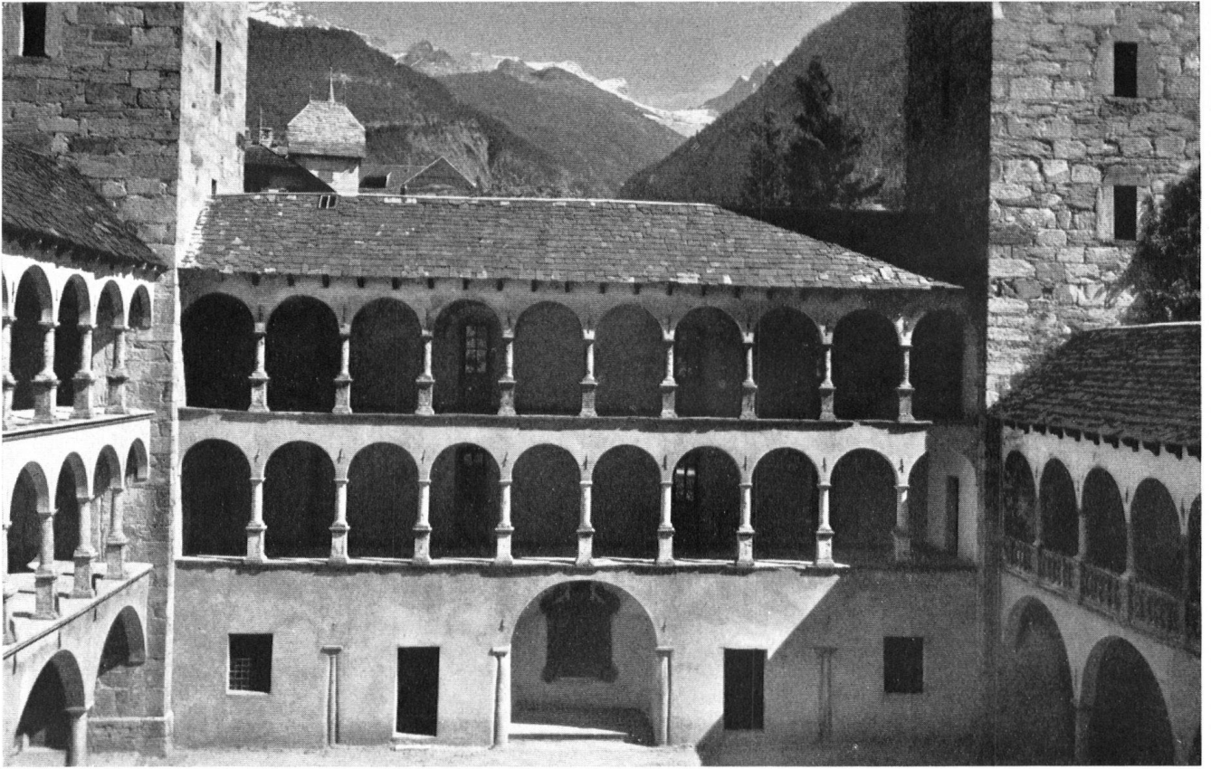
Le palais de Stockalper, élevé à Brigue de 1641 à 1647 par le fameux Grand-bailli du Valais, est depuis 1948 la propriété de la Ville. Les arcades magnifiques avaient été murées au XIXe siècle; celles du premier étage ont été libérées il y a deux ans; le rez-de-chaussée attend son tour. (Voir « Heimatschutz » 1948, No 4, p. 120—124.)
