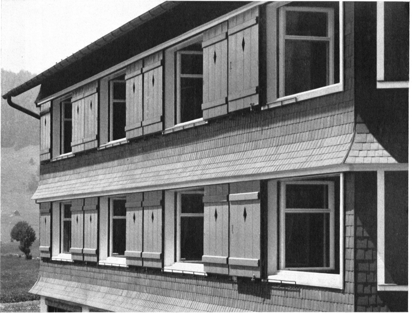
Gutes Beispiel einer Fassadenverkleidung mit den heute üblichen kleinformatigen Eternitschiefeln.
