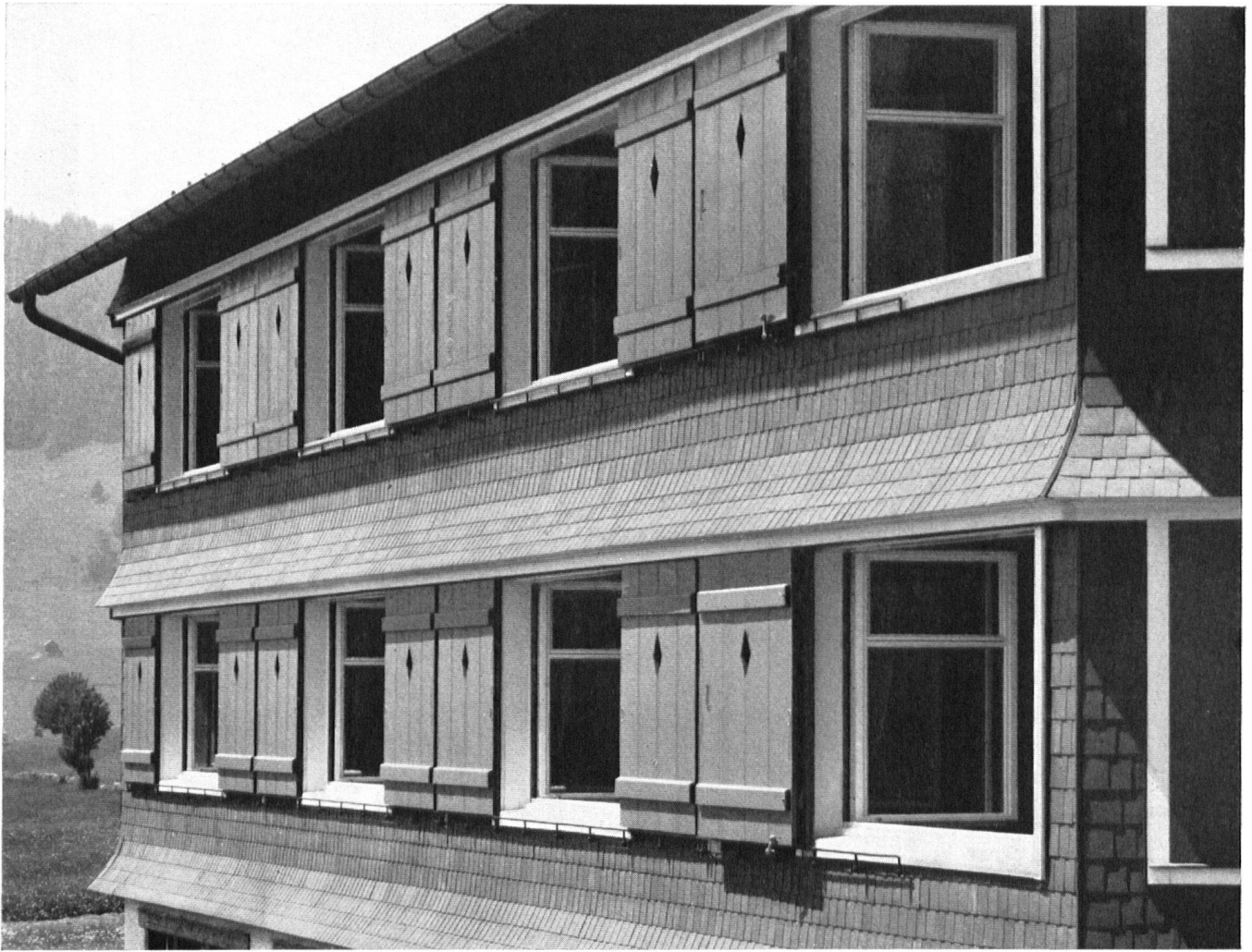
Gutes Beispiel einer Fassadenverkleidung mit den heute üblichen kleinformatischen Eternitschiefern.
