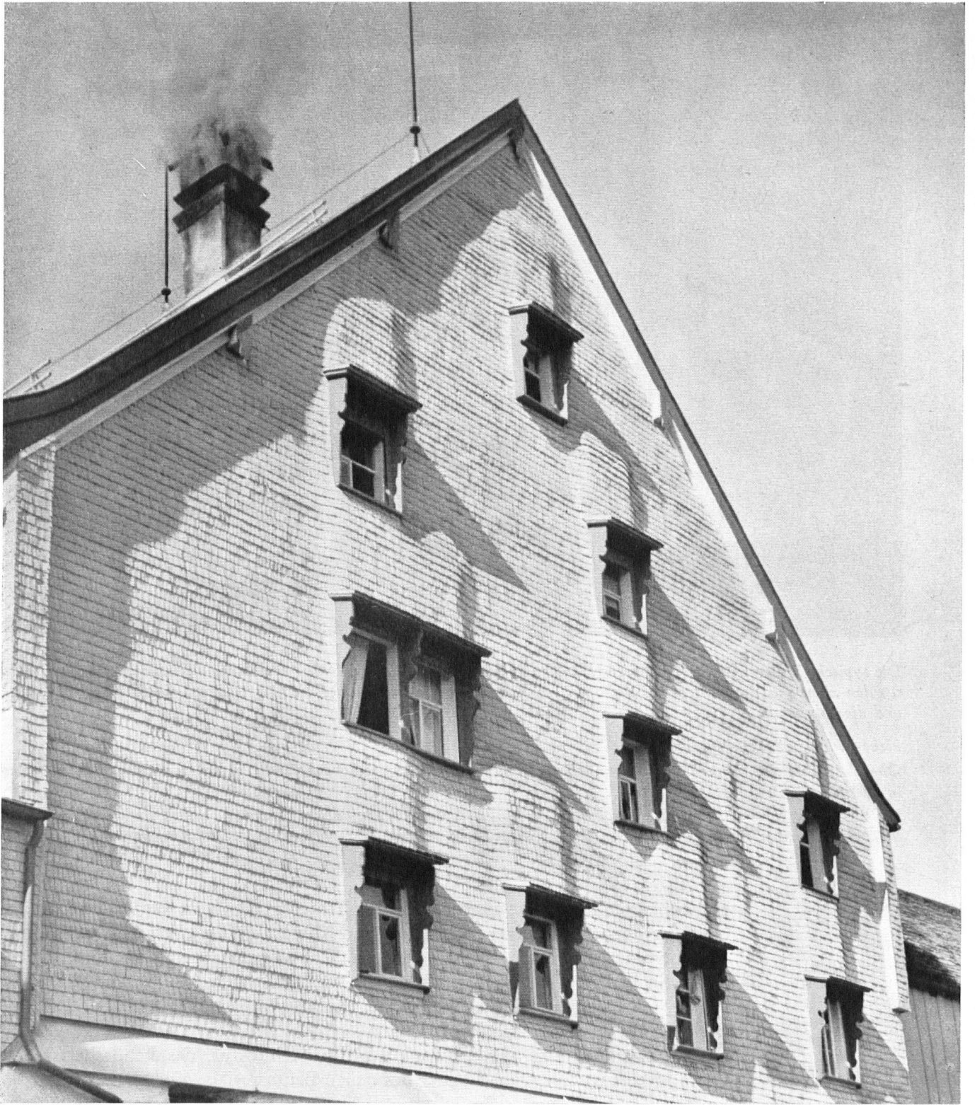
Die folgenden Bilder zeigen verschiedene Arten von Wandverkleidungen. Hier ein Appenzeller Haus mit seinem prächtigen, hellgestrichenen Schindelmantel.
