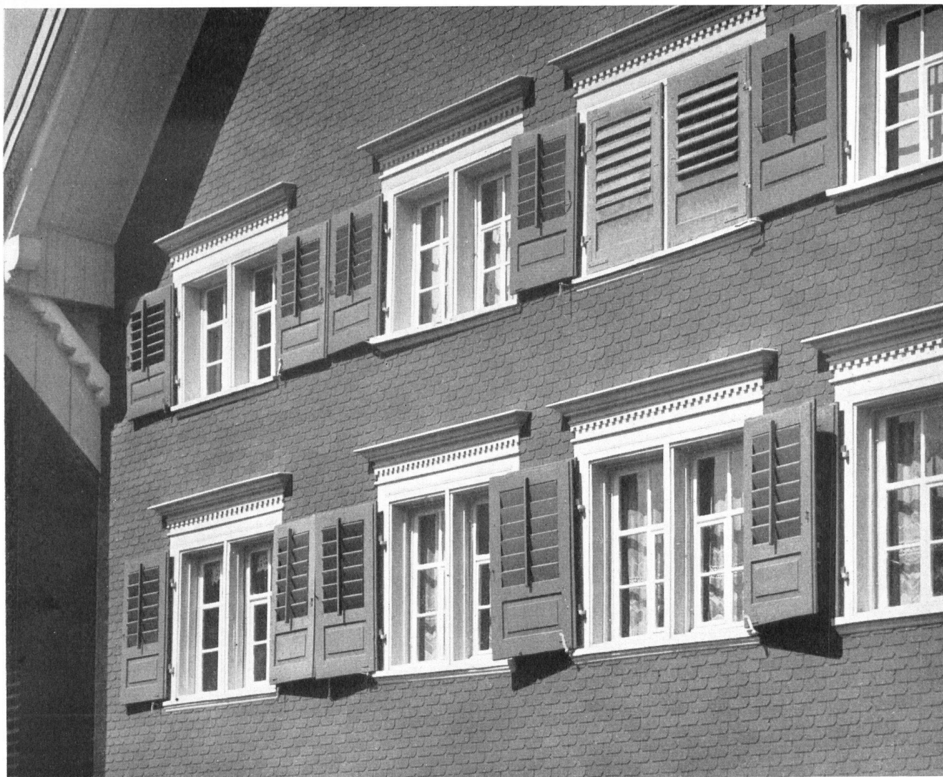
Neue Eternitwand mit zierlichen, den Holzschindeln nachgebildeten Eternitschiefern.
