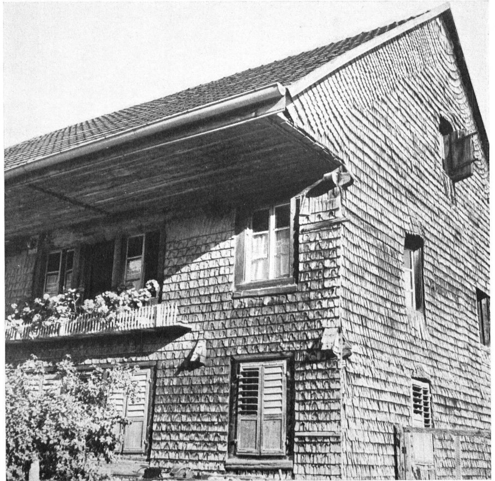
Bauernhaus in Pringy (Freiburg). Wetterseite mit einfachen Holzschindeln, die Schauseite mit ausgeschnittenen Schindeln verziert.
