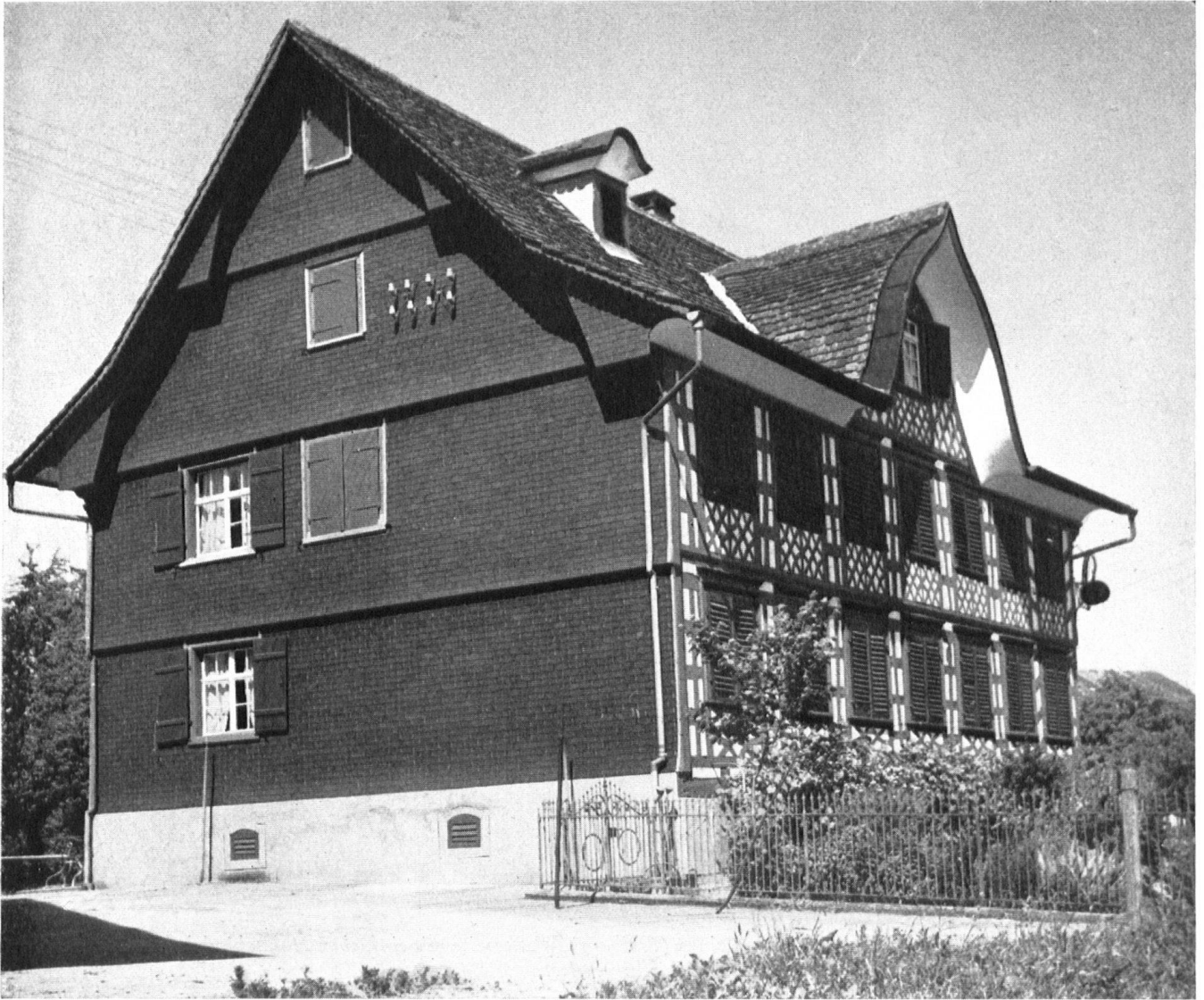
Thurgauer Gasthof. Reicher Riegelbau des 18. Jahrhunderts. Die heikle Westwand (Schlagregen) mit kleinformatigen Eternit-schiefern verkleidet, ergibt eine auch für den Heimatschutz annehmbare Lösung.
