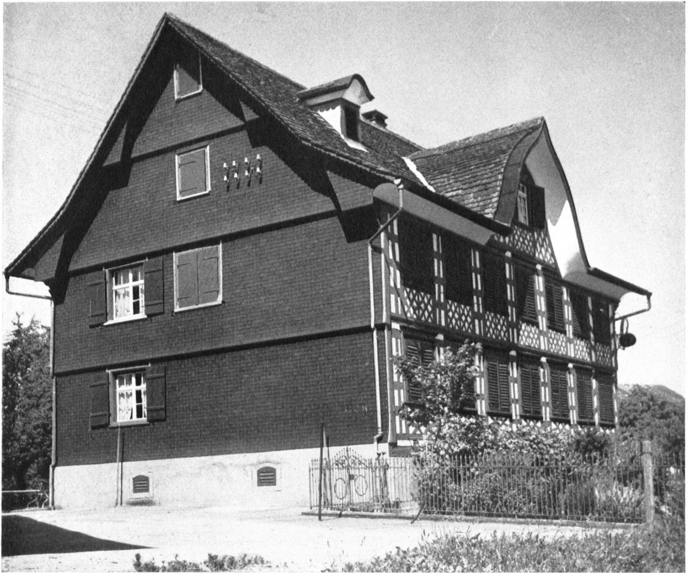
Thurgauer Gasthof. Reicher Riegelbau des 18. Jahrhunderts. Die beikle Westwand (Schlagregen) mit kleinformatigen Eternitschiefern verkleidet, ergibt eine auch für den Heimatschutz annehmbare Lösung.
