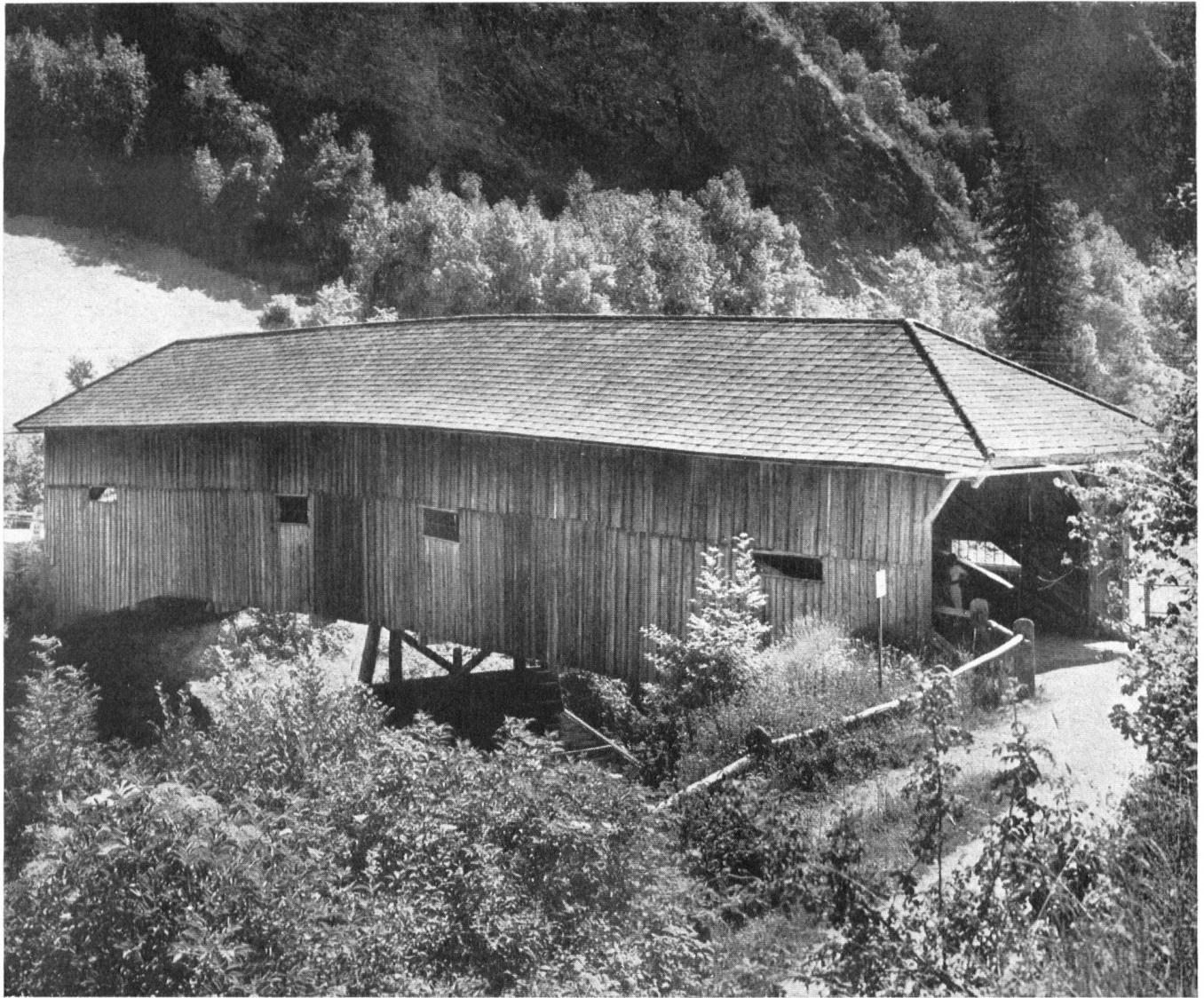
Holzbrücke im Domleschg mit Dach aus braunen Eternitplatten. Die Wirkung ist gefällig, doch können die harten Linien an den Dachkanten nicht übersehen werden; man vergleiche sie mit den Schindeldächern auf Seiten 6 und 7.
