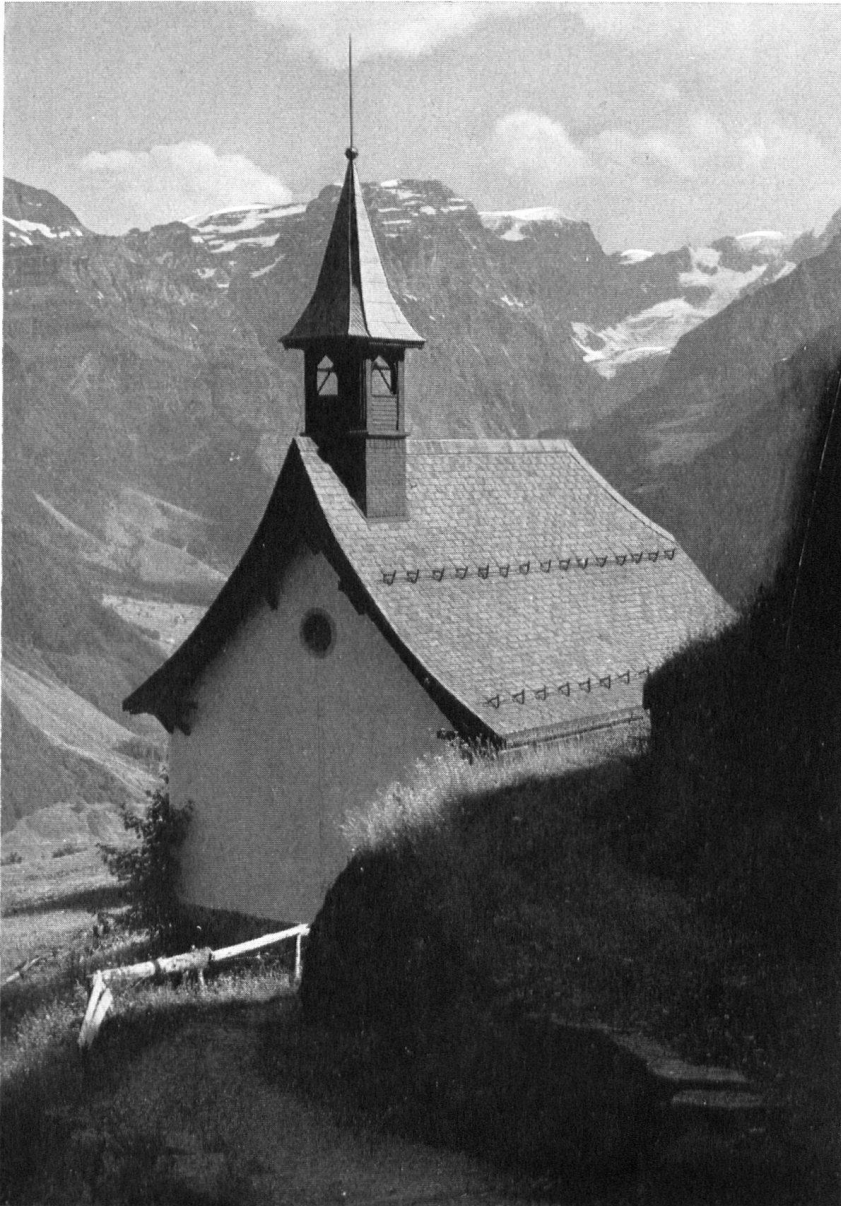
Bergkirchlein im Glarnerland. In Format und Farbe paßt sich das Eternit angenehm ein. Der weiche Fluß und der seidene Schimmer eines echten Schindeldaches bleiben jedoch unerreicht.
