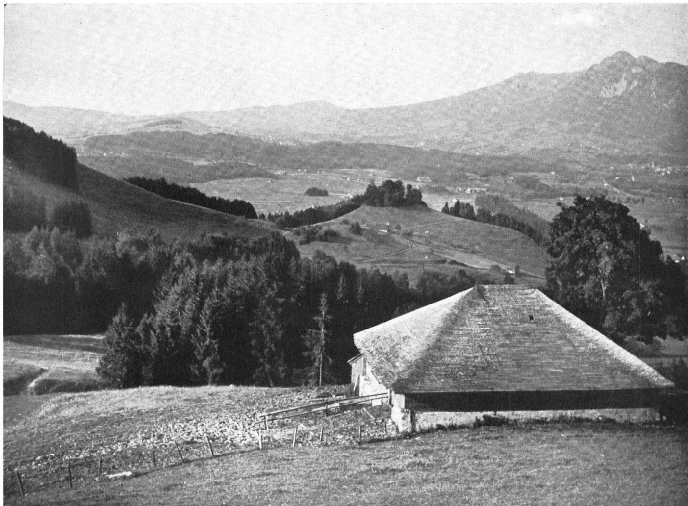
Sennhütte im Greyerzerland mit silbern schimmerndem Schindeldach, das sich wie ein weicher Mantel über die Dachkanten legt. Für einsam stehende Alphütten in herkömmlichen Schindelgebieten ist diese Art der Bedachung immer noch die schönste und auch wegen der Brandgefahr zu verantworten.
