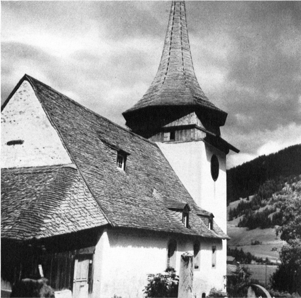
Kirche in Gsteig, Berner Oberland. Auch hier ist erkennbar, wie die Schindeln sich der Gestalt des Daches anschmiegen (Dachfenster!).
