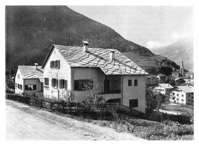
Im Wallis verwendet man Schieferplatten, die sich verhältnismäßig dünn und großflächig brechen lassen. Unser Bild zeigt die Verwendung dieses vorzüglichen Bedachungsmaterials an neuen Bauten für die Angestellten eines Industrieunternehmens in Visp.
