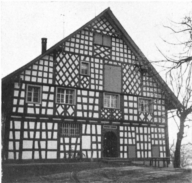
Die reiche Riegelfront eines Bauernhauses in Häggenschwil, an deren Instandstellung der St. Galler Heimatschutz einen Beitrag leistete.
