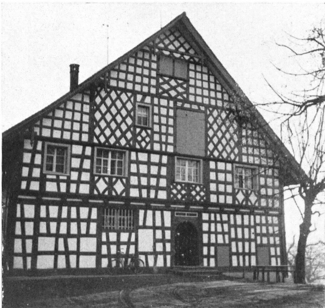
Die reiche Riegelfront eines Bauernhauses in Häggenschwil, an deren Instandstellung der St. Galler Heimatschutz einen Beitrag leistete.
