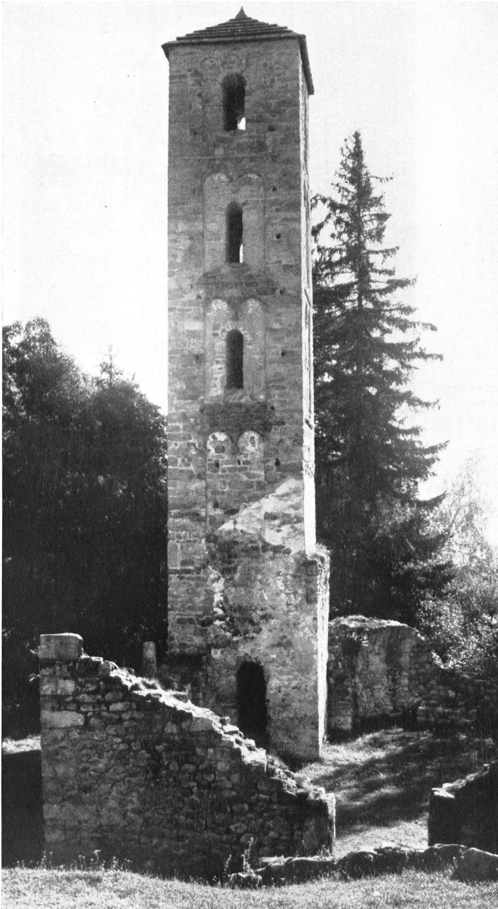
Ruine Jörgenberg bei Wal- tensburg (Graubünden) mit dem Turm der ehemaligen Georgskapelle aus dem 11. Jahrhundert. An die Siche- rung des Mauerwerkes wurde ein Beitrag gegeben.
