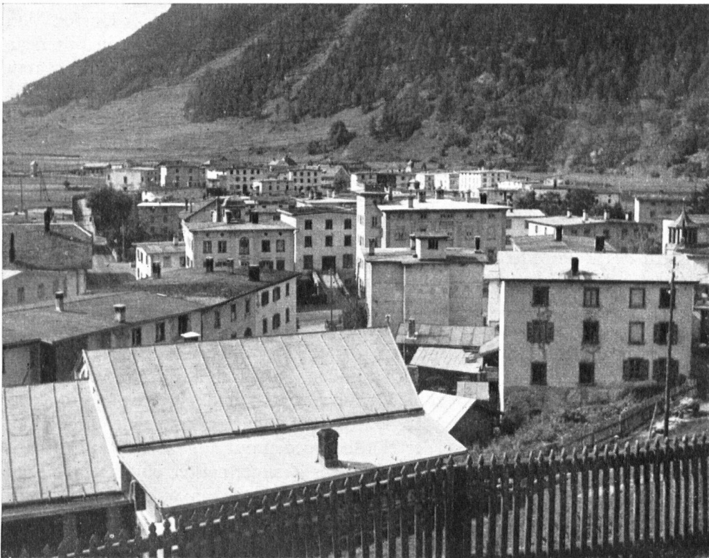
Wie ein abgebranntes Dorf früher aufgebaut wurde: rasch, billig, banal. Unser Bild zeigt Zernezh, wie es nach dem Brand von 1872 auferstand und bis zum heutigen Tage geblieben ist. Les reconstructions « criminelles ». En 1872, Zernezh en Engadine brûla. On a rebâti le noble village, mais le phénix a péri dans les cendres.
