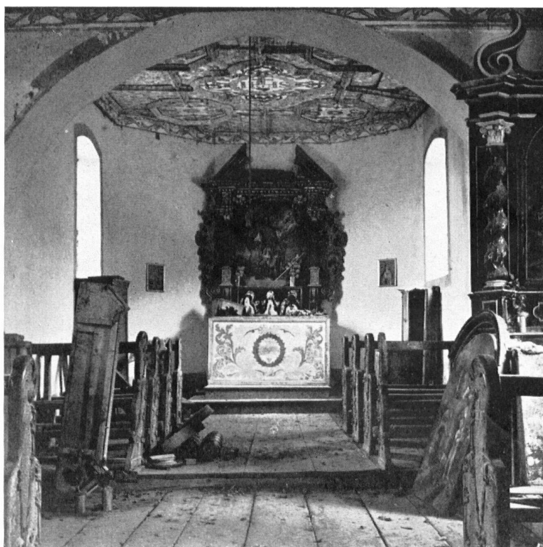
Das schöne Innere schien dem rettungslosen Zerfall entgegen zu gehen, durch die reichgemalte Decke trüfelte das Regenwasser, und die faulenden Bretter drohten herunterzustürzen.
