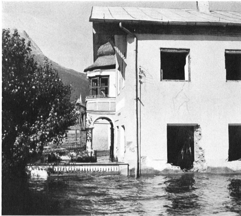
Ein versinkendes Haus in Reschen, dessen obere Teile erst noch abgebrochen werden müssen. Diesen Winter wird das Wasser erst bis zur Kennmarke 85 steigen; am 1. Juli 1950 wird es 12 m höher sein und alles überfluten. A Reschen, maison inondée dont la partie supérieure doit encore être démolie. Cet hiver, l'eau ne dépassera pas la cote 85; au 1er juillet 1950, le niveau sera de 12 m. plus élevé et recouvrira tout.
