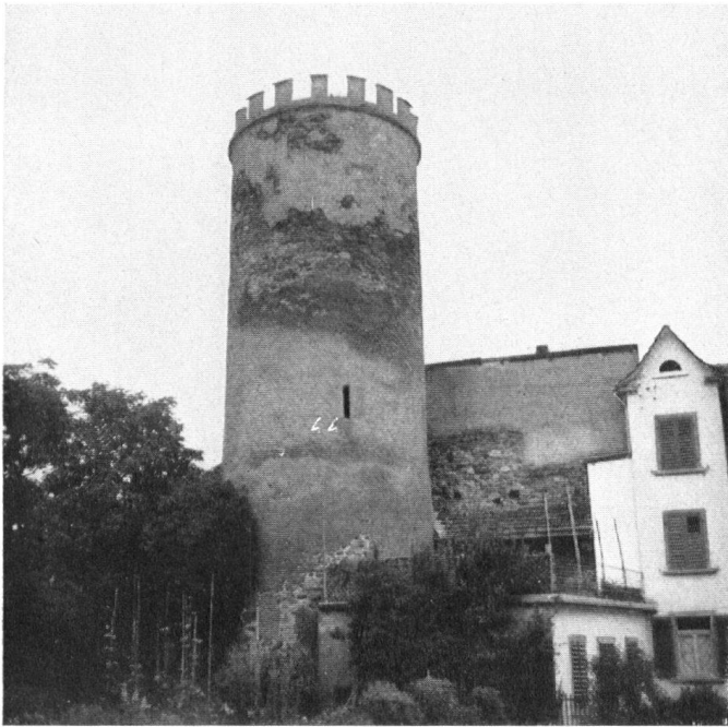
Aus dem reichen Mittelland: Der zerbröckelnde Hexenturm in Mellingen. Ehedem ein Spitzturm, der erst im vorigen Jahrhundert bei einer unsachverständigen »Erneuerung« mit einem Zinnenkranz bekrönt wurde. La tour des Sorciers, à Mellingen, se lézarde. Elle avait naguère un toit magnifique, en forme d'entonnoir; une restauration malencontreuse, du XIXe siècle, a supprimé le beau poinçon qui la terminait. Nella regione ricca dell'Altipiano: la Torre delle Streghe di Mellingen in rovina. Era un tempo una torre acuminata; la merlatura venne costruita nel secolo scorso in occasione di un preteso restauro.
