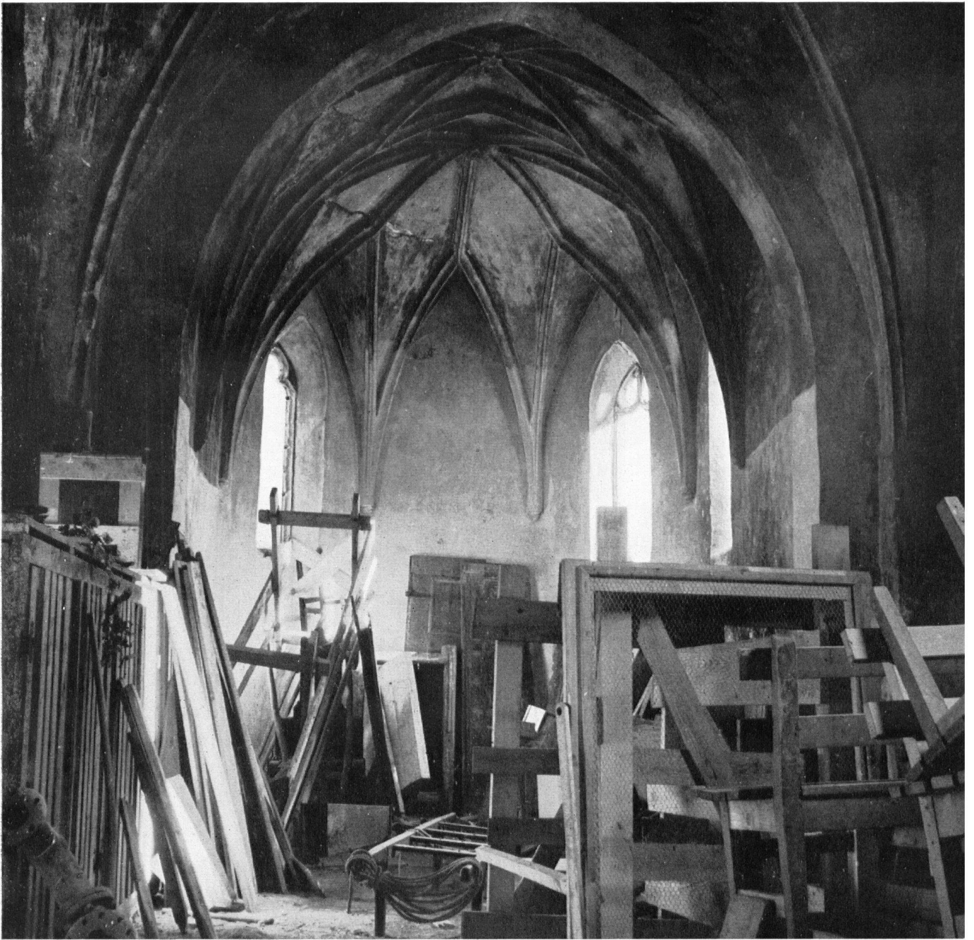
Zernez im Unterengadin. Die spätgotische Sebastians-Kapelle aus dem Jahre 1490. Unter dem Verputz befinden sich wertvolle Fresken. Bild rechts: Die Kreuzrippen im Chor, durch Teer geschwärzt, rissig und bergwärts durchfeuchtet. Die evangelische Kirchgemeinde von Zernez ist willens, das köstliche kleine Baudenkmal instandstellen zu lassen, kann aber die über Fr. 30 000.— betragenden Kosten nicht selber aufbringen und bittet den Heimatschutz um einen Beitrag aus der bevorstehenden Sammlung. A Zernez, en Engadine, la chapelle de Saint-Sébastien, qui date de 1490. Un épais badigeon recouvre ses fresques. La voûte, crevassée par l'humidité, est noircie de goudron. La paroisse évangélique est prête à entreprendre une restauration, mais la dépense est
