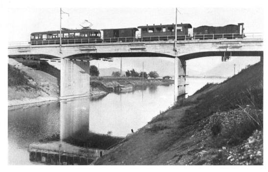
Das unlängst aufgetane "Tor des Fortschrittes": unter der höher gelegten Bahnbrücke auf dem Rapperswiler Damm können nun die Dampfschiffe in den Obersee einfahren.
