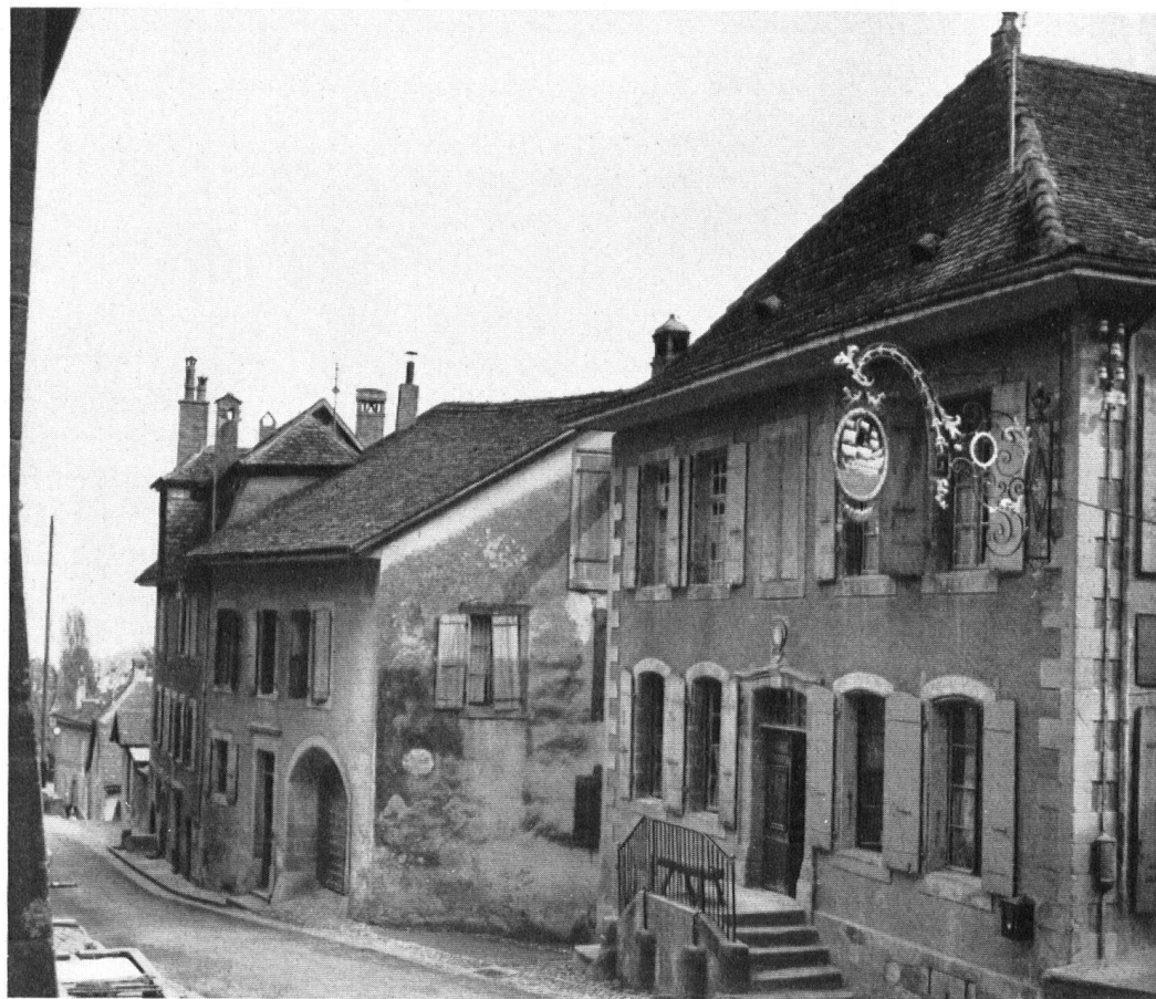
L'auberge de l'Onde à Saint-Saphorin... et son enseigne. Alte Dorfkultur in der Lavaux: das Gasthaus »zur Welle« in St-Saphorin. — Sein Aushängeschild. Photo: E. Gos
