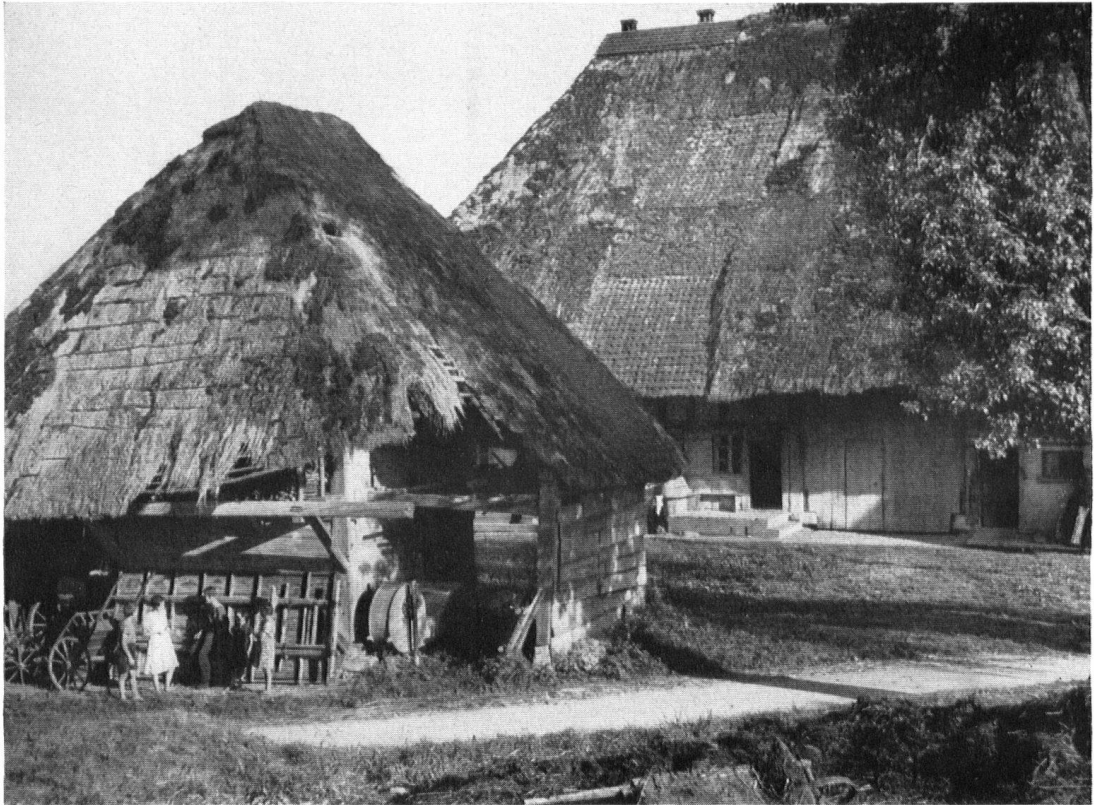
Anblick der gleichen Häusergruppe von einer andern Seite. Man beachte den traurigen Zustand des Schopfdaches und die mit Ziegeln eingeflickten Stellen auf dem Dach des Hauptgebäudes. Les mêmes bâtiments vus sous un autre angle. Les dégradations et les empiècements commencent; on remplace peu à peu le chaume par la tuile.
