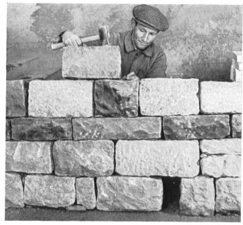
Schichtenartiges Trockenmauerwerk. Sorgfältige Arbeit sichert guten Verband und damit Standfestigkeit, Tragkraft und Bestand der Mauer.
