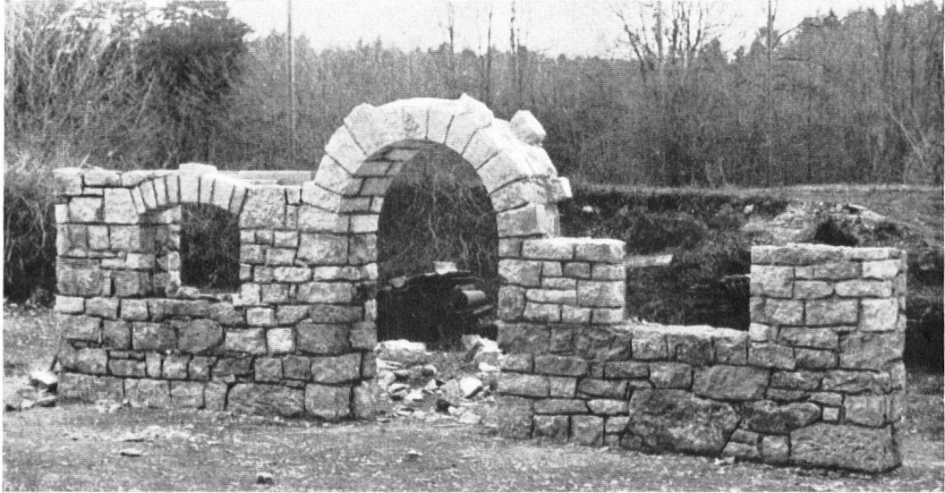
Unregelmäßiges Bruchstein-Mauerwerk aus bankigen, ausgelesenen Steinen, hauptsächlich mit dem Hammer bearbeitet, schichtenartig vermauert. Übung in der Ausführung von Wänden, Pfeilern, Anschlägen, Stichbogen und Gewölben.
