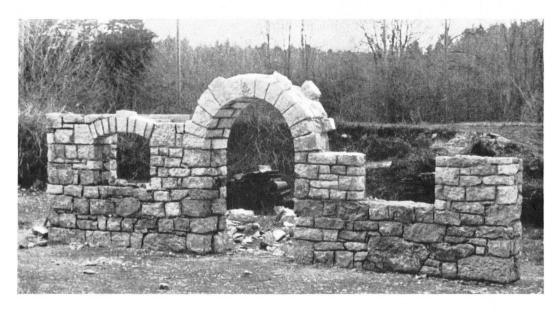
Unregelmäßiges Bruchstein-Mauerwerk aus bankigen, ausgelesenen Steinen, hauptsächlich mit dem Hammer bearbeitet, schichtenartig vermauert. Übung in der Ausführung von Wänden, Pfeilern, Anschlägen, Stichbogen und Gewölben.
