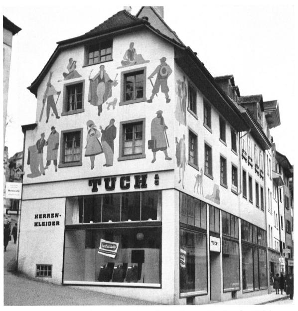
Die Schaufensterslächen sind im Maßstab zum Gebäude viel zu mächtig. Der obere Teil der Giebelfassade wird durch die horizontale Gurtung vollständig abgeschnitten. Der Reiz des anspruchslosen, aber gefälligen Giebelhauses ist verloren gegangen.
