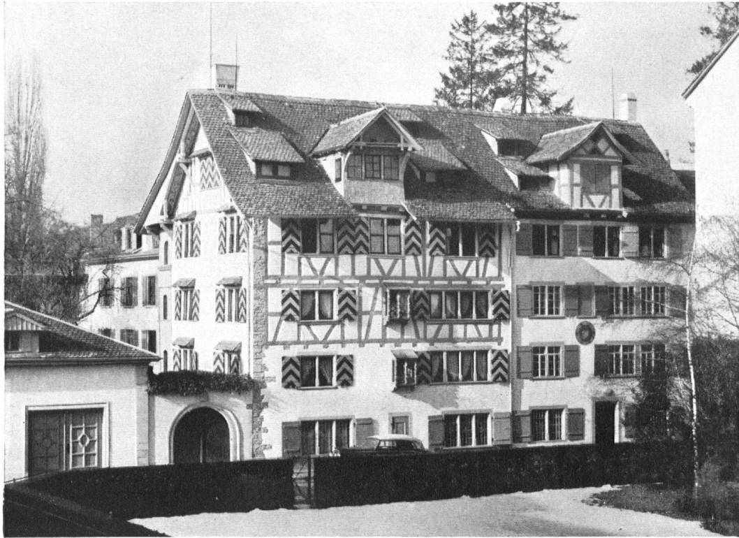
Der wiederbergestellte Bodmersche „Schanzenhof“. Man beachte die originellen „Klebdächli“ über den Fenstern an der Giebelseite und die hübschen Erker.
