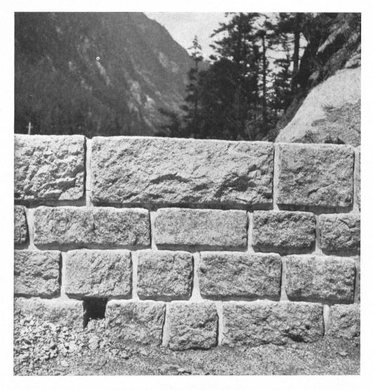
Schematisch zusammengesetzte Brüstungsmauer an der Sustenstraße. Die schweren Blöcke an der Oberkante widersprechen dem Gefühl für natürliche Gewichtsverteilung.
