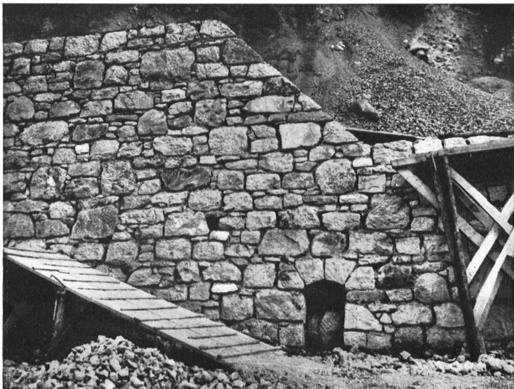
Mauerwerk aus Dolomit von derselben Baustelle wie oben, noch nicht verfugt, von 1939!
