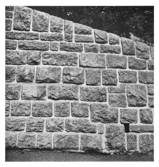
Stützmauer an der neuen Sustenstraße. Die Steine sind sorgfältig behauen, stecken jedoch in einem viel zu dicken Zementbett. Der einzelne Stein "trägt" nicht mehr, sondern "schwimmt" im erstarrten Zementbrei. Man beachte die "Aufsteller" an der Oberkante.
