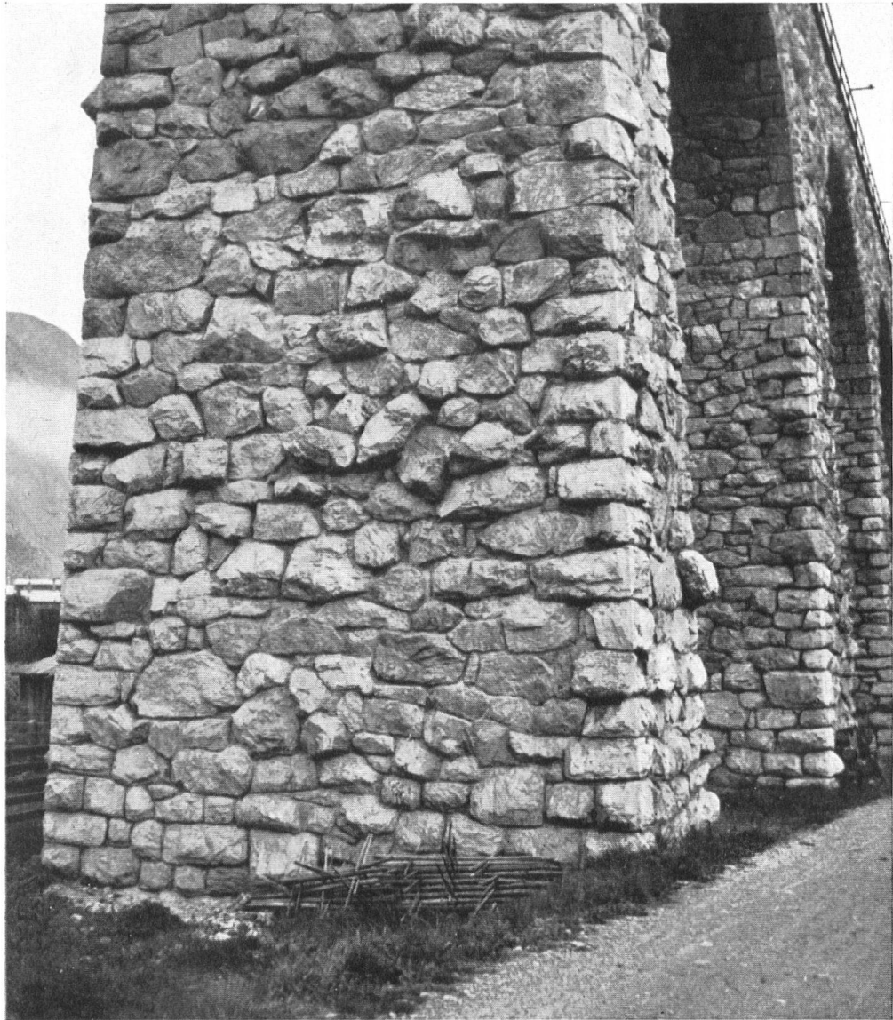
Mauerwerks Pfeiler von 1300: vorbildlich schönes Schichtenmauerwerk in Nagelstuh.
