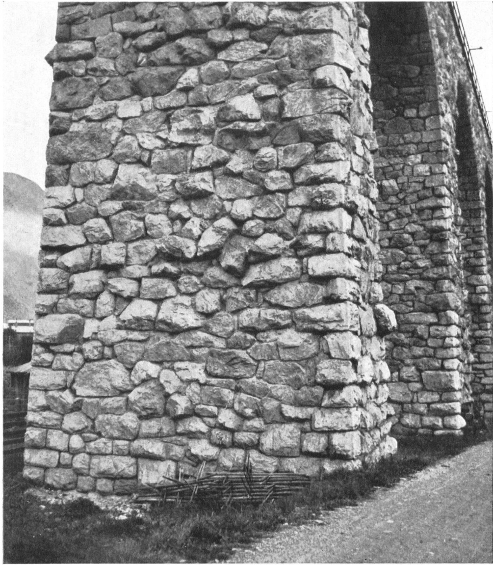
Mauerwerks Pfeiler von 1300: vorbildlich schönes Schichtenmauerwerk in Nagelfluh.
