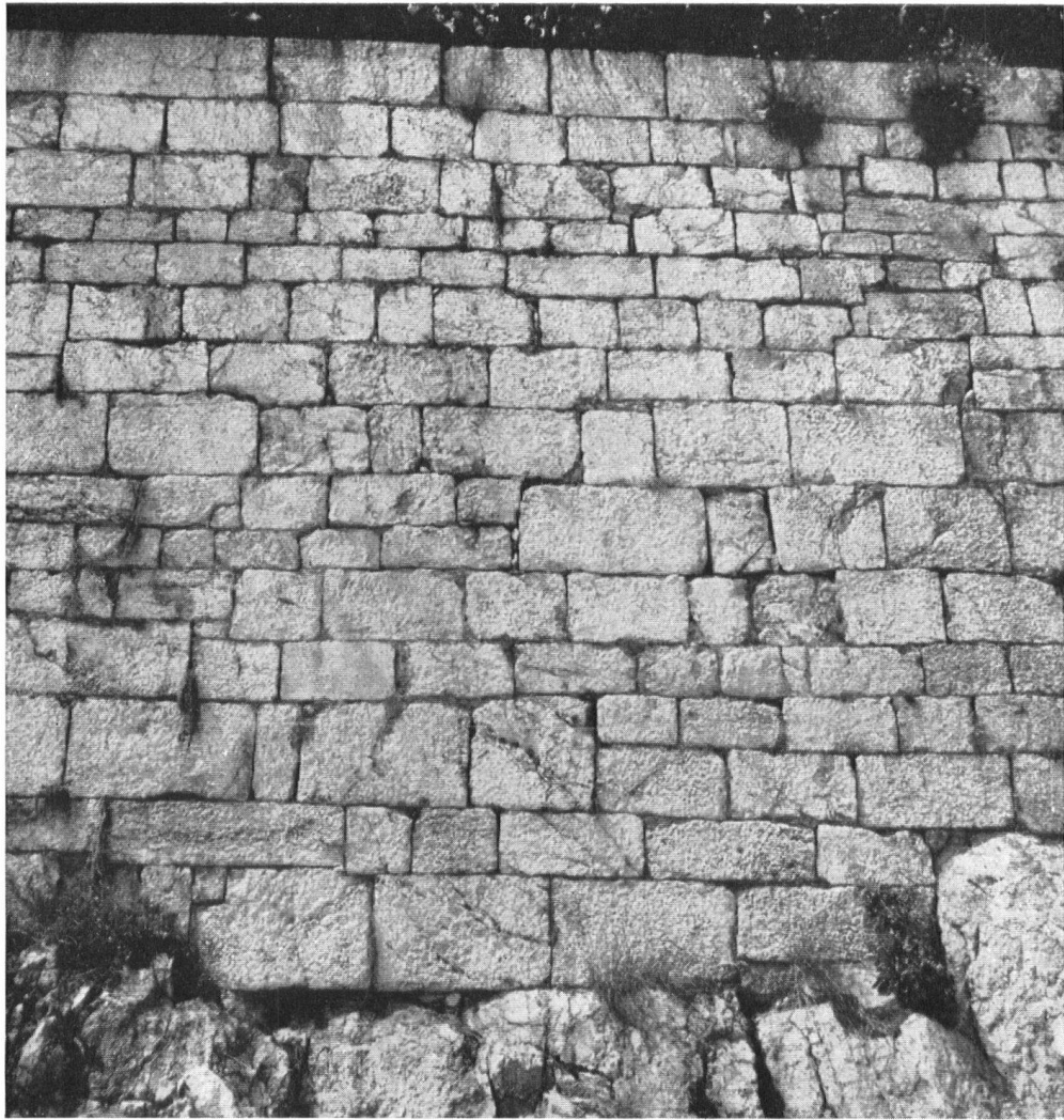
Prachtvolle Trockenmauer eines unbekannten ländlichen Meisters (in unmittelbarer Nähe der Schmierarbeit auf vorstehender Seite).
