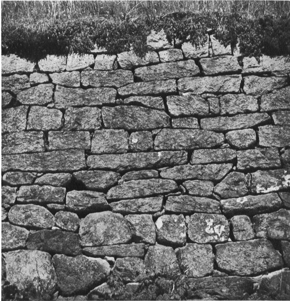
Altes vorbildliches Trockenmauerwerk an der Böschung einer schweizerischen Alpenstraße. Excellent appareillage en pierres sèches d'un ancien talus, dans les Alpes suisses.
