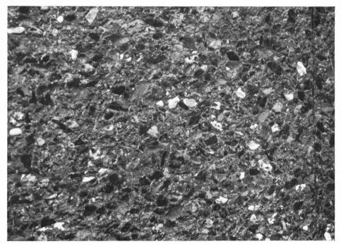
Gut (3 cm tief) gespitzter Beton aus sehr buntem Schotter mit bis zu 7 cm Korndurchmesser. Bétonnage à gros grains, repiqué à 3 cm., bon travail.
