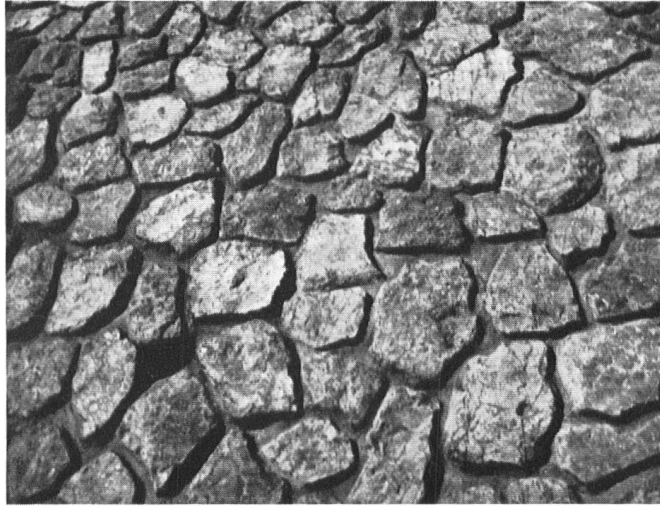
Mauerwerk aus Dolomit von 1934 bei Reichenhall; pflasterartig mittels Zement zu „Zyklopen“-Mauerwerk zusammengeklebt.
