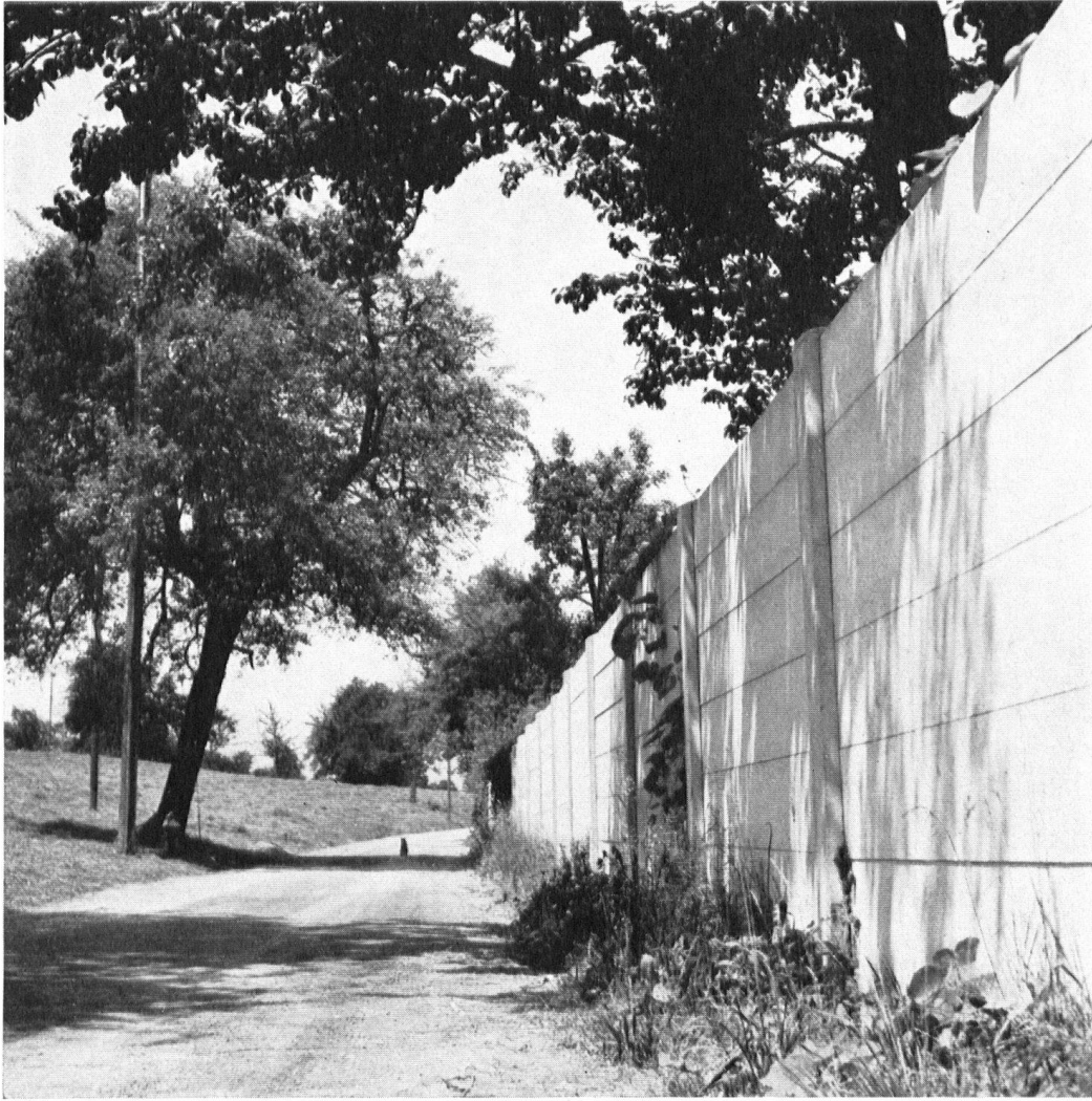
Wand aus gegossenen Zementbrettern, einen neuen Herrnsitz vom ehemaligen Aussichtsweg brutal abriegelnd. — Cette énorme muraille vient brutalement déparer le chemin du rêve.
