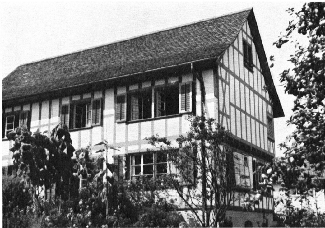
Neuer Riegelbau. — Maison à pans de bois, récemment bâtie selon les traditions locales.
