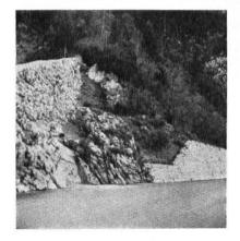
2. Beispiel der Wirkung des Mauerwerkes in der Natur. Links: wildes Mauerwerk: gute Lösung. Rechts: glattes Mauerwerk. Mitte: Mutterfelsen. (Axenstrasse.)
