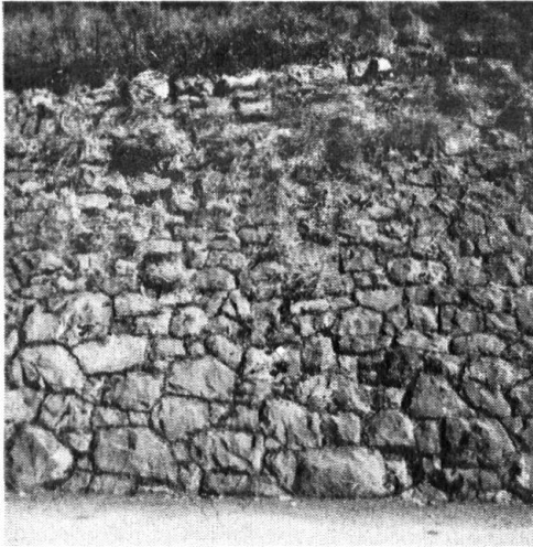
15. Altes, unregelmässiges Trockenmauerwerk. (Axenstrasse.)
