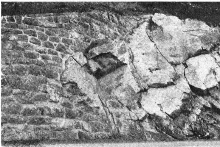
6. Harmonische, unauffällige Ueberleitung des Mauerwerkes in die Felswand. (Strasse Gersau-Vitznau, Kt. Schwyz.)
