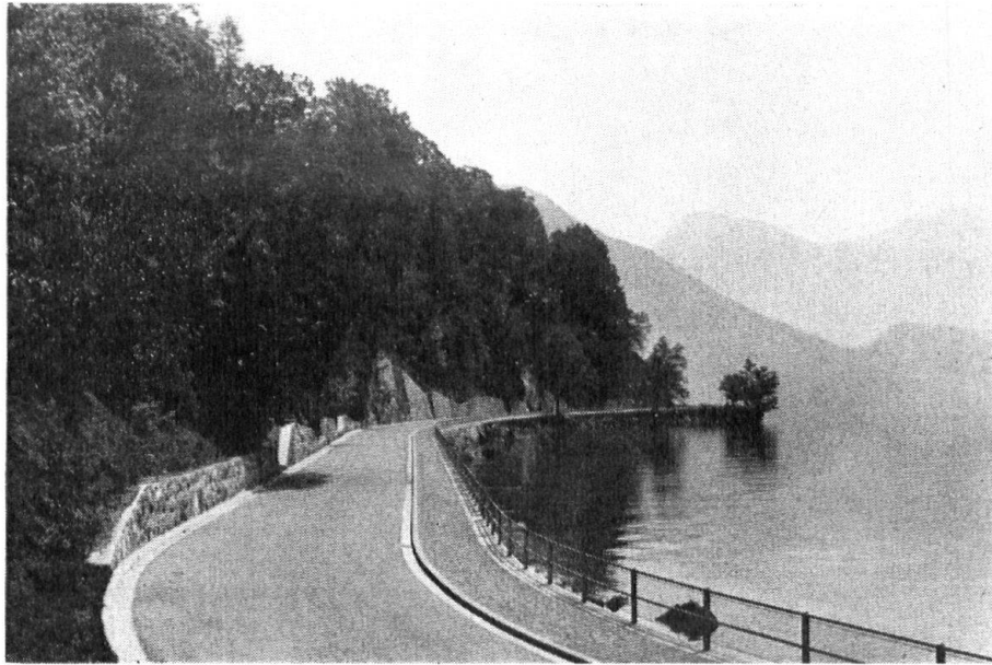
28. Zwischen den Eisenpfosten ist als Kinderschutz ein engmaschiges Drahtnetz gespannt. (Weggis-Vitznau 1934.)
