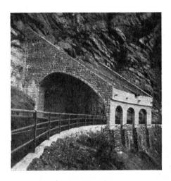
34. **Schutzgalerie.** Die Kurve über dem Portal bildet eine unregelmässige Linie; dazu wirkt die geradgezogene Oberkante hart. Die senkrechten Wände bestehen aus Beton. Er ist leider zu schwach mit dem Spitzhammer bearbeitet, wodurch die Fläche zu hart wirkt.
