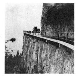
23. Die Betonung der Strassenlinienführung durch einen schmalen Betonstreifen über dem Bruchsteinmauerwerk lässt den technischen Sinn des Werkes klar erkennen. Die Frage erhebt sich, ob nicht eine Gewölbekonstruktion statt eines Balkens angezeigt gewesen wäre.
