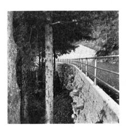
11. Der Uebergang von der Halde zum Bossenmauerwerk der Stützmauer mit dem Abschluss eines schmalen Betonrandes wirkt ruhig. (Axenstrasse.)
