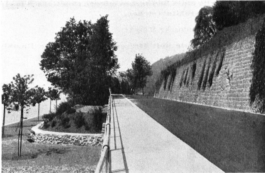
7. Einfühlen des Strassenzuges in die Landschaft. Abtreppung gegen den See. Bergwärtiges Anpassen der 5 m hohen Futter-Mauer an den Felsen. Starker Efeu-wuchs. (Strasse Vitznau-Weggis.) Erstellungsjahr 1934.
