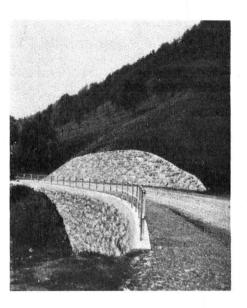
Mur d'arête en coupe d'un glissement de terrain.
