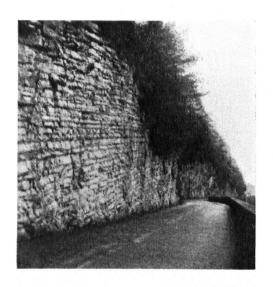
19. Kein Mauerwerk, sondern Kieselkalkfelsen. Hier kommt nur ein dünnschichtiges Parallel-Schichtenmauerwerk in Frage. (Axenstrasse.)
