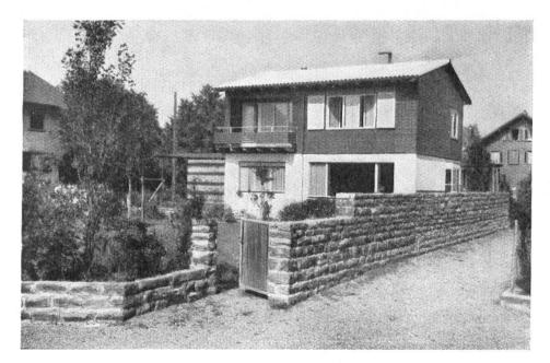
Kleines Einfamilienhaus in Thun-Dürrenast. 1936. Erdgeschoss der Bodennebel wegen in Beton. 1. Stock: Skelettbau, mit horizontaler gebeizter Schalung. Bedachung grauer Welleternit (jetzt auch braun erhältlich). Arch. W. Bärfuss, Thun.
