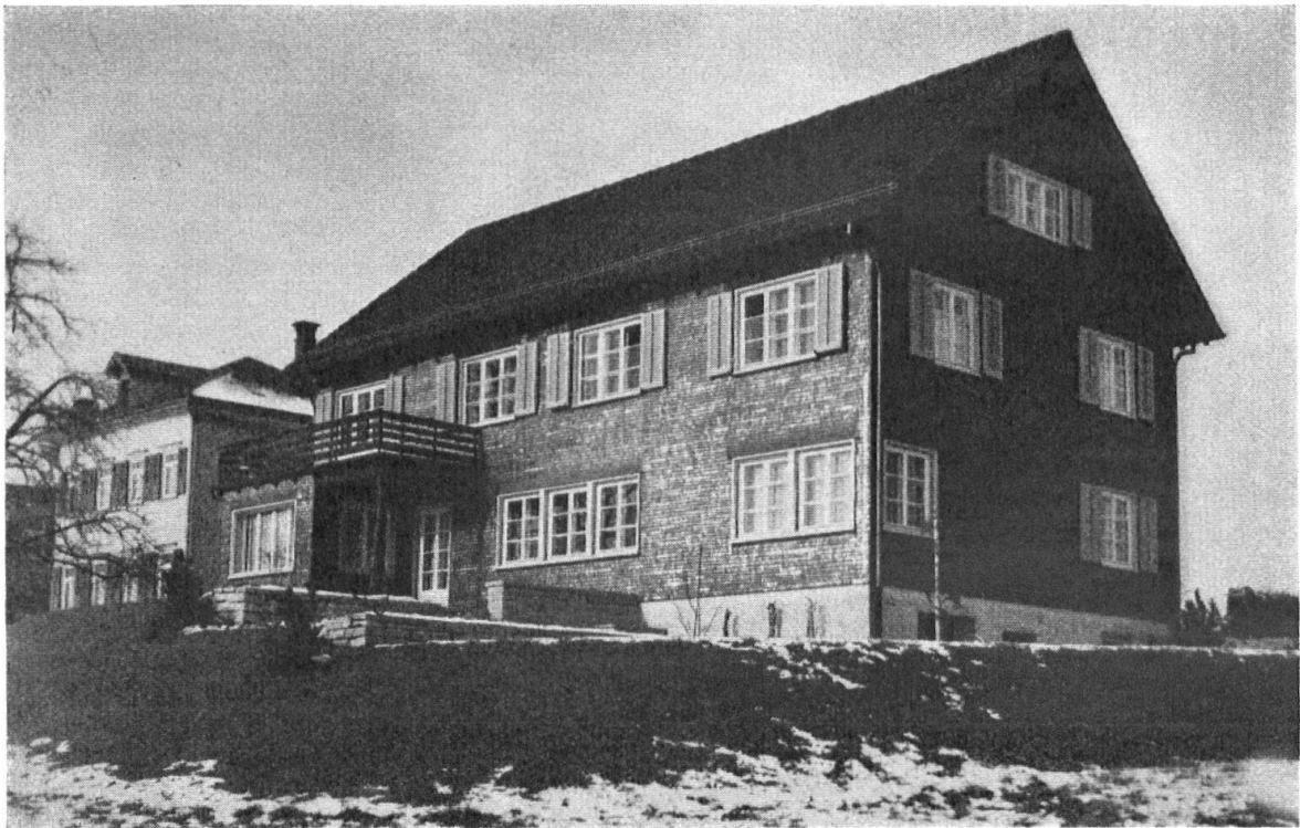
Arzthaus in Flawil, Kanton St. Gallen. Modernisiertes Riegelwerk, verschalt mit lackiertem Schindelschirm. Arch. F. Largiadèr, Riehen. Unten Arzthaus mit rechts Lehrerhaus von Arch. Zöllig, Flawil. Gärten durchgehend.
