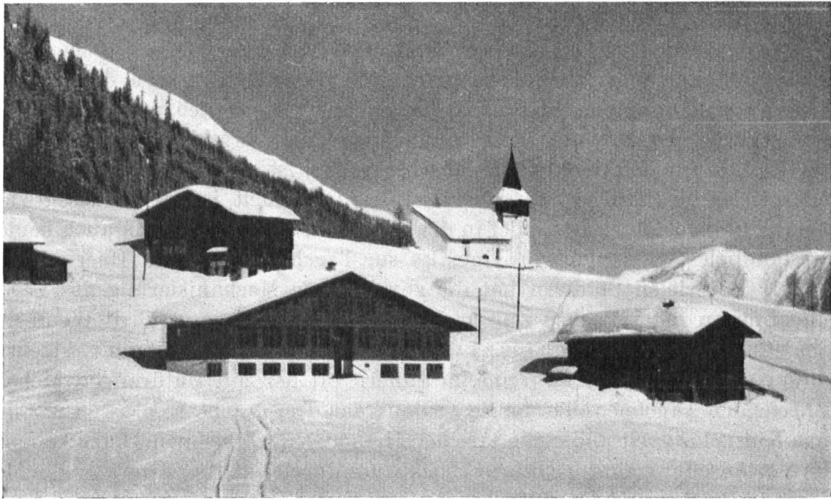
Neues Schulhaus in Davos-Frauenkirch. Skelettbau mit Schalung mit lackiertem Schindelschirm. Im massiven Untergeschoss Turnsaal und Duschen. Rud. Gaberel, Arch. B.S.A., Davos. Rechts das alte, trostlose, um 1900 gebaute Schulhaus.
