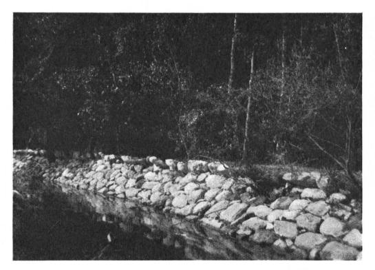
Steinvorlage als Ufersicherung. — Digue pour empêcher l'érosion.
