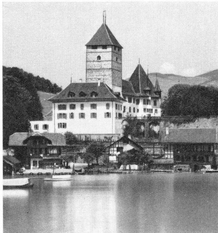
Das Schloss Spiez vor und nach seiner Renovation. Le château de Spiez, avant et après la reconstruction.
