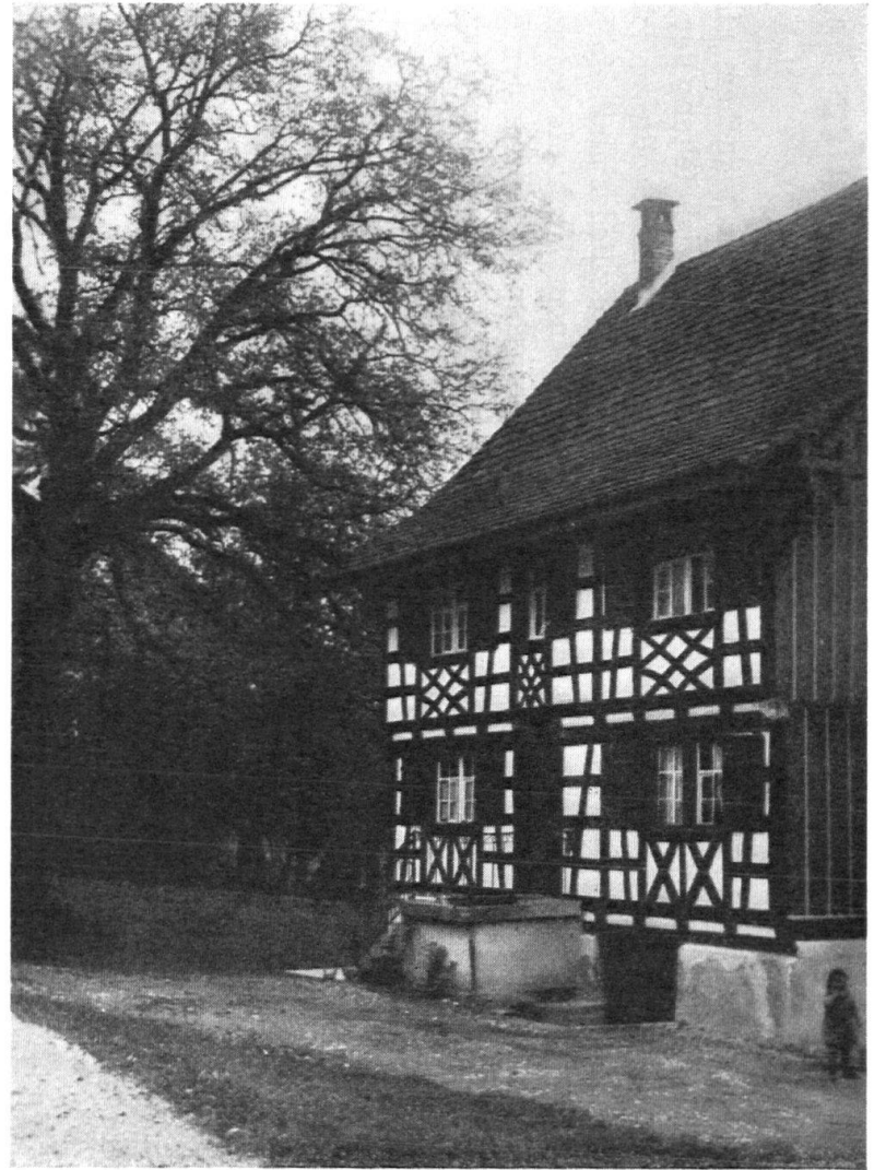
Riegelhaus in Mallisdorf.
