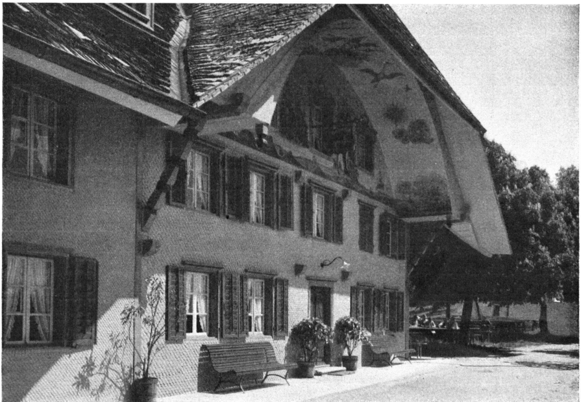
Blick in die Ründe des Hauses, die uns das Zusammenklingen von Hauswand und Verschalung zeigt. — Un regard sous le toit nous fait voir, comme une seule composition couvre la partie supérieure de la façade et les planches du toit.
