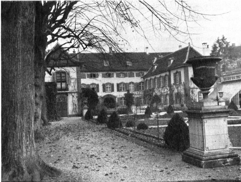
Der Wirtenbergerhof mit seinem reizvollen Park musste der neuen Kunstsammlung weichen. — Pour construire un nouveau Musée on vient de démolir un charmant hôtel rococo avec son parc qui était une merveille.
