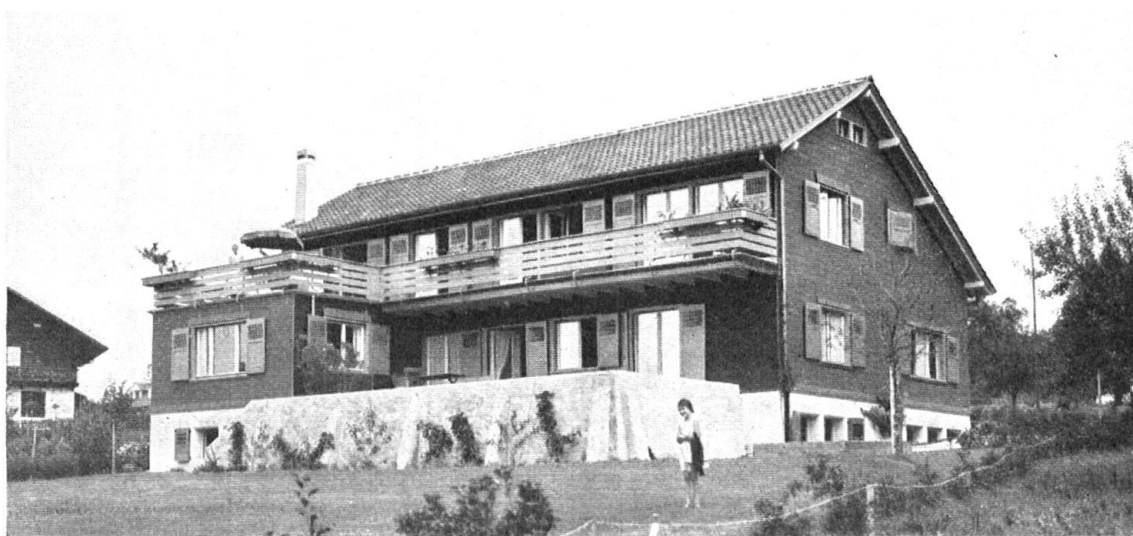
Landhaus in Muri bei Bern, von Architekt Läubli, Holzbau A.G., Lungern (Brünig). — Maison de campagne à Muri, près Berne.
