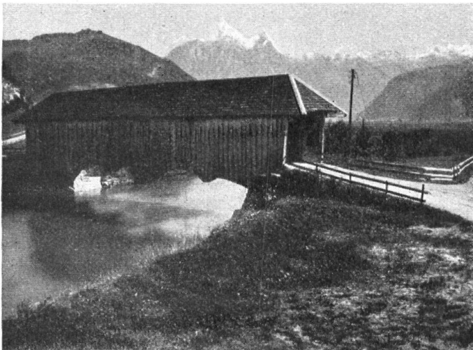
Holzbrücke in der Steinau.
