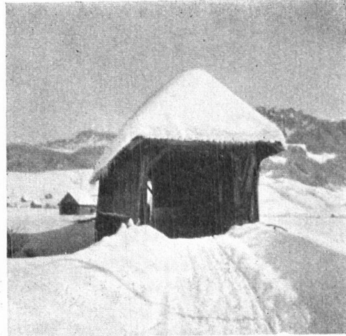
Holzbrücke in Willerzell.
