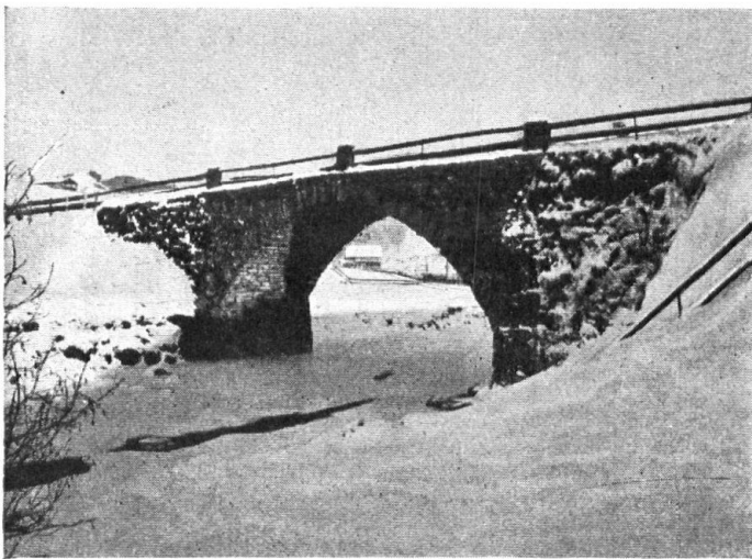
Die alte Bogenbrücke in der Jässenen.
