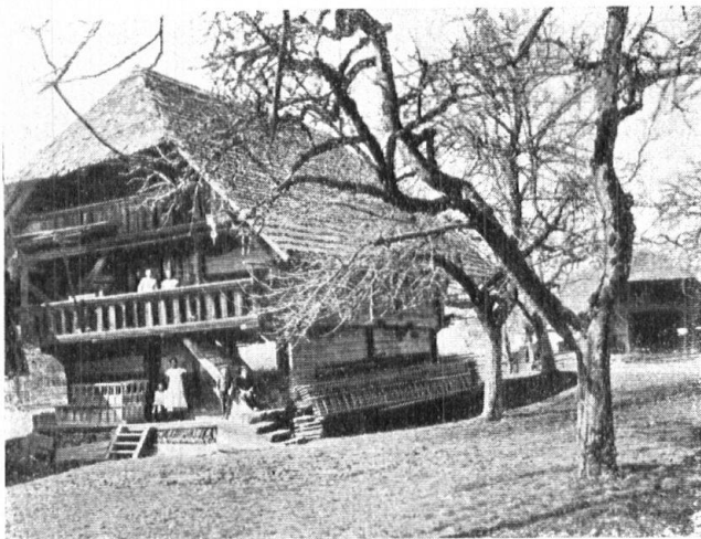
Speicher aus dem Jahre 1697. Mittleres Geschoss zweiräumig. Würfel fries an den Rahmenhölzern der Lauben. — Grenier, construit en 1697. L'étage moyen à deux pièces. La balustrade des galeries est décorée de frises cubiques.
