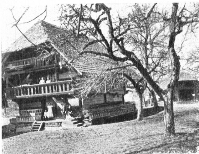
Speicher aus dem Jahre 1697. Mittleres Geschoss zweiräumig. Würfel fries an den Rahmenhölzern der Lauben. — Grenier, construit en 1697. L'étage moyen à deux pièces. La balustrade des galeries est décorée de frises cubiques.
