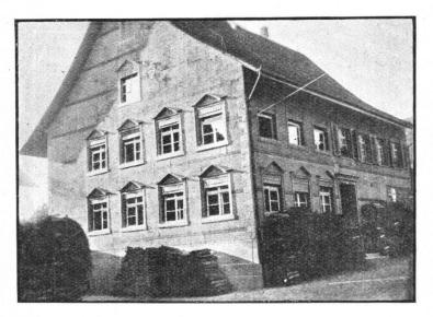
Abb. 10. Schulhaus in Nussbaumen, Thurgau. Alter Riegelbau mit Blech verkleidet, das Sandsteinquader und rote Backsteine vortäuscht. - Fig. 10. La maison d'école de Nussbaumen, canton de Thurgovie. Ancienne construction en pan de bois, revêtue de fôle, dont la peinture imite le mur en pierres de tailles et en briques.
