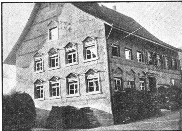
Abb. 10. Schulhaus in Nussbaumen, Thurgau. Alter Riegelbau mit Blech verkleidet, das Sandsteinquader und rote Backsteine vortäuscht. — Fig. 10. La maison d'école de Nussbaumen, canton de Thurgovie. Ancienne construction en pan de bois, revêtue de tôle, dont la peinture imite le mur en pierres de tailles et en briques.
