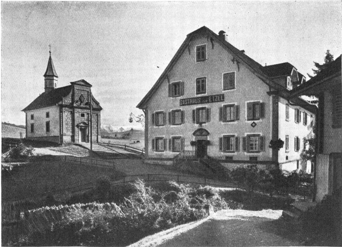
Abb. 1. Gasthaus und Kapelle St. Meinrad auf der Etzelpasshöhe (Phot. J. Gaberell, Thalwil) — Fig. 1. L'hôtel et la chapelle de saint Meinrad sur le col de l'Étzel (Phot. J. Gaberell, Thalwil).
