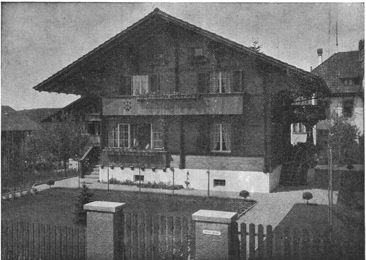
GRIBI & Co. A.G., BURGDORF - Chaletfabrik - Kantonal bern. Ausstellung Goldene Medaille
