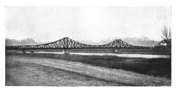
Abb. 8. Eiserne Brücke über den Rheindurchstich bei Diepoldsau. Die geschwungene Linie des Obergurtes bringt die Wirkungsweise der tragenden Kräfte trefflich zum Ausdruck. — Fig. 8. Pont de fer sur le canal du Rhin, à Diepoldsau. La belle courbe de l'arche médiane met admirablement en évidence la solidité du pont.
