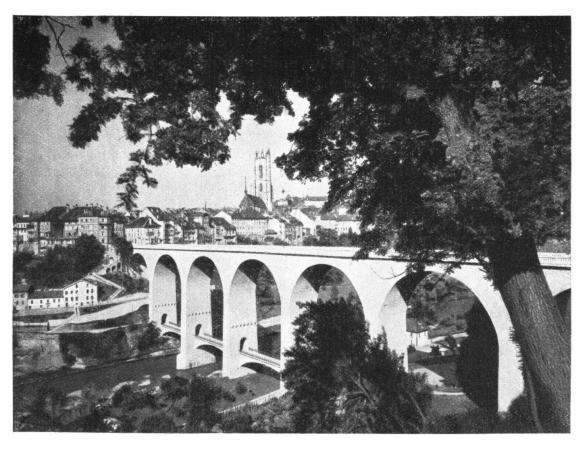
Abb. 15. Neue Zähringerbrücke in Freiburg. Imposantes Bauwerk aus Beton und Eisenbeton, als Ersats der alten, dem neuzeitlichen Verkehr nicht mehr genügenden Hängebrücke. Phot. Wehrli-Verlag, Kilchberg. — Fig. 15. Le nouveau pont de Zähringen, à Fribourg. Construction imposante en béton et béton armé. Il a remplacé l'ancien pont suspendu, lequel était devenu insuffisant. Phot. Wehrli, édition, Kilchberg.
