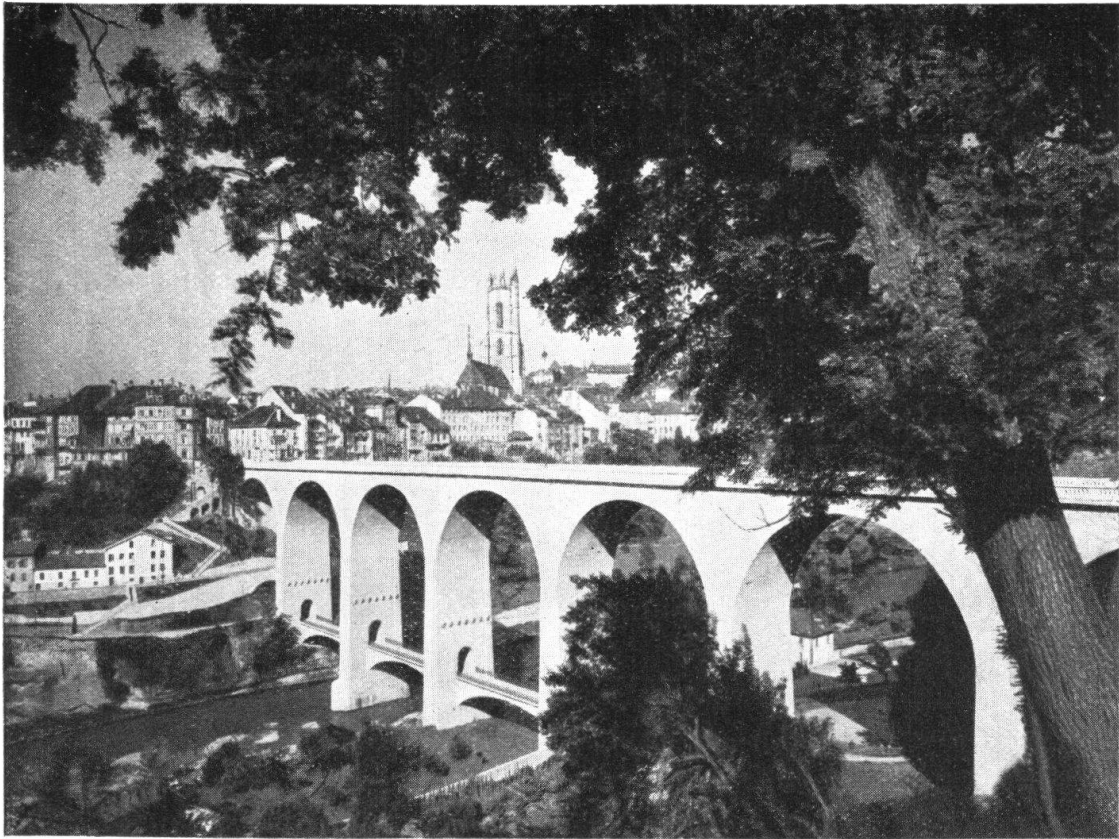
Abb. 15. Neue Zähringerbrücke in Freiburg. Imposantes Bauwerk aus Beton und Eisenbeton, als Ersatz der alten, dem neuzeitlichen Verkehr nicht mehr genügenden Hängebrücke. Phot. Wehrli-Verlag, Kilchberg. — Fig. 15. Le nouveau pont de Zähringen, à Fribourg. Construction imposante en béton et béton armé. Il a remplacé l'ancien pont suspendu, lequel était devenu insuffisant. Phot. Wehrli, édition, Kilchberg.
