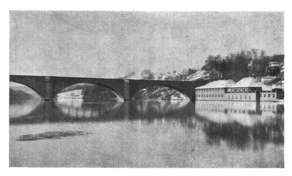
Abb. 14. Neue Eisenbetonbrücke über den gestauten Rhein bei Eglisau. Die vollen Zwickel geben bei der hochgelegenen Fahrbahn und der weiten Bogenstellung der Brücke ein etwas schweres Ansehen. — Fig. 14. Le nouveau pont en béton armé au-dessus du barrage du Rhin, près d'Eglisau. La grande hauteur du tablier, la longueur extraordinaire de la portée donnent à ce pont un aspect quelque peu lourd.
