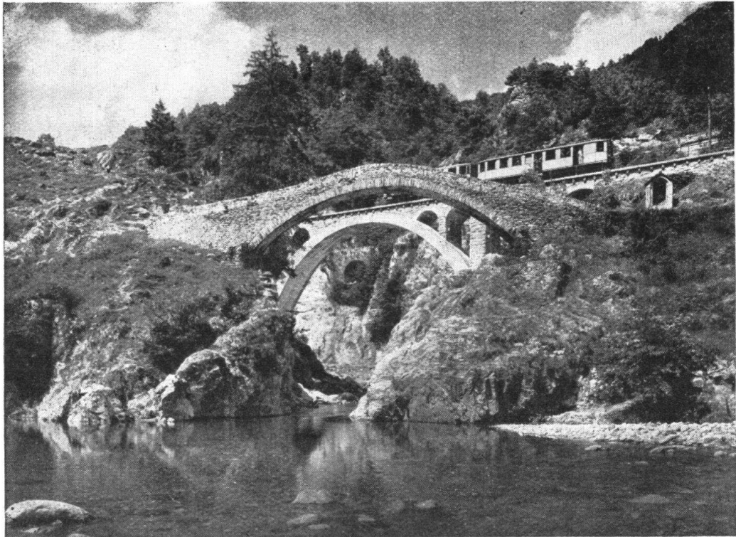
Abb. 1. Brücken im Centovalli, Tessin. Vorn eine alte Steinbrücke mit beidseitig ansteigender Fahrbahn; hinten die neue Eisenbahnbrücke mit Betongewölbe und Aufbauten mit Mauerwerkverkleidung. — Fig. 1. Deux ponts dans le Centovalli, Tessin. Devant, un ancien pont de pierre à dos d'âne (rampe des deux côtés); derrière, le pont du chemin de fer avec une arche en béton.
