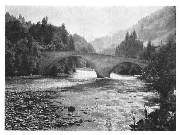
Abb. 5. Alte Steinbrücke über die Saane, Kanton Freiburg. Verschieden grosse Offnungen, den Gründungsverhältnissen angepasst, der Scheitel über dem höhern Bogen. — Fig. 5. Vieux pont de pierre sur la Sarine, canton de Fribourg. Arches de grandeurs différentes, dont les dimensions sont déterminées par la nature des fondations. La plus grande arche marque le sommet du pont.
