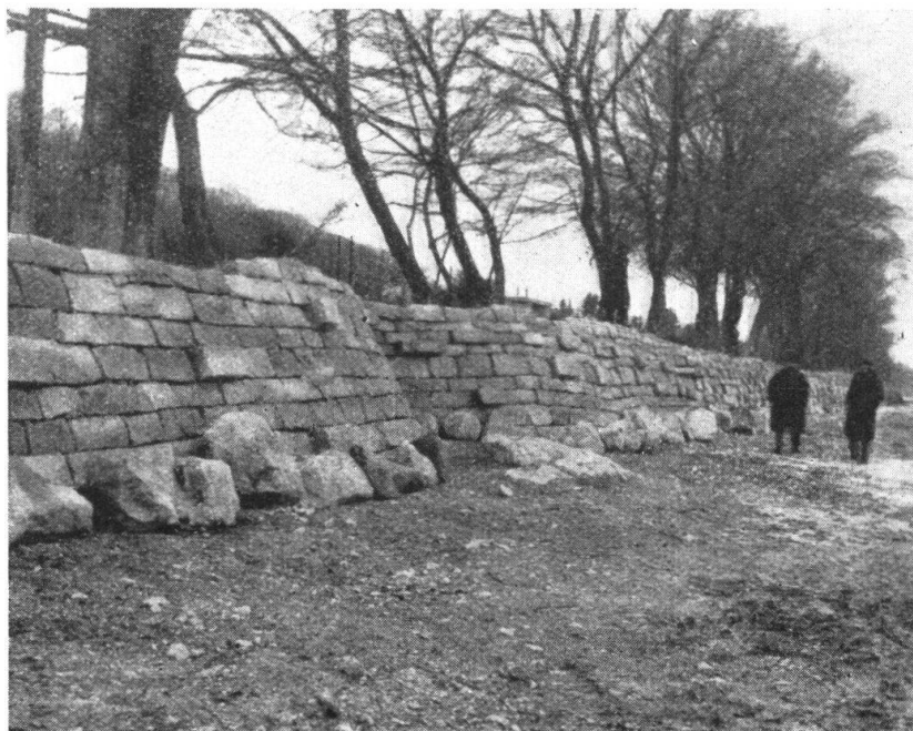
Abb. 19. Neuer Uferschutz am Bodensee, südlich von Moosburg. 1928. Fig. 19. Nouvelle manière de protéger les grèves du lac de Constance. Environs de Moosburg.
