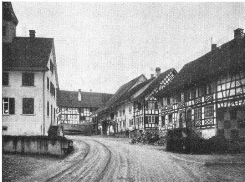
Abb. 6. Dorfstrasse in Guntalingen. Das Zürcher Riegelhaus in freier Aufreihung an der steigenden Strassenkurve. — Fig. 6. Une rue du village de Guntalingen. La maison zurichoise en colombage. Alignement libre; heureuse disposition des maisons à l'angle de la rue.
