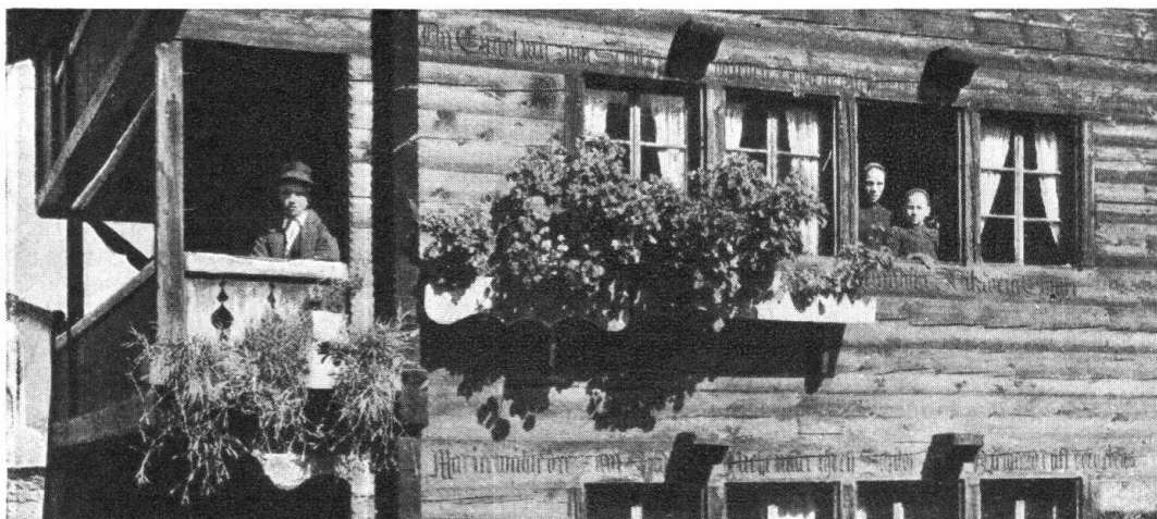
Abb. 1. Das Murmannhaus in Kippel. Teilstück. Das schönste Lötschentaler Haus aus dem 18. Jahrhundert, mit Kerbschnittornamenten und Inschriften. — Fig. 1. La maison de la famille Murmann à Kippel. Détail de cette maison, qui est la plus belle du Lötschental et qui date du XVIII e siècle. Décoration d'inscriptions gravées.
