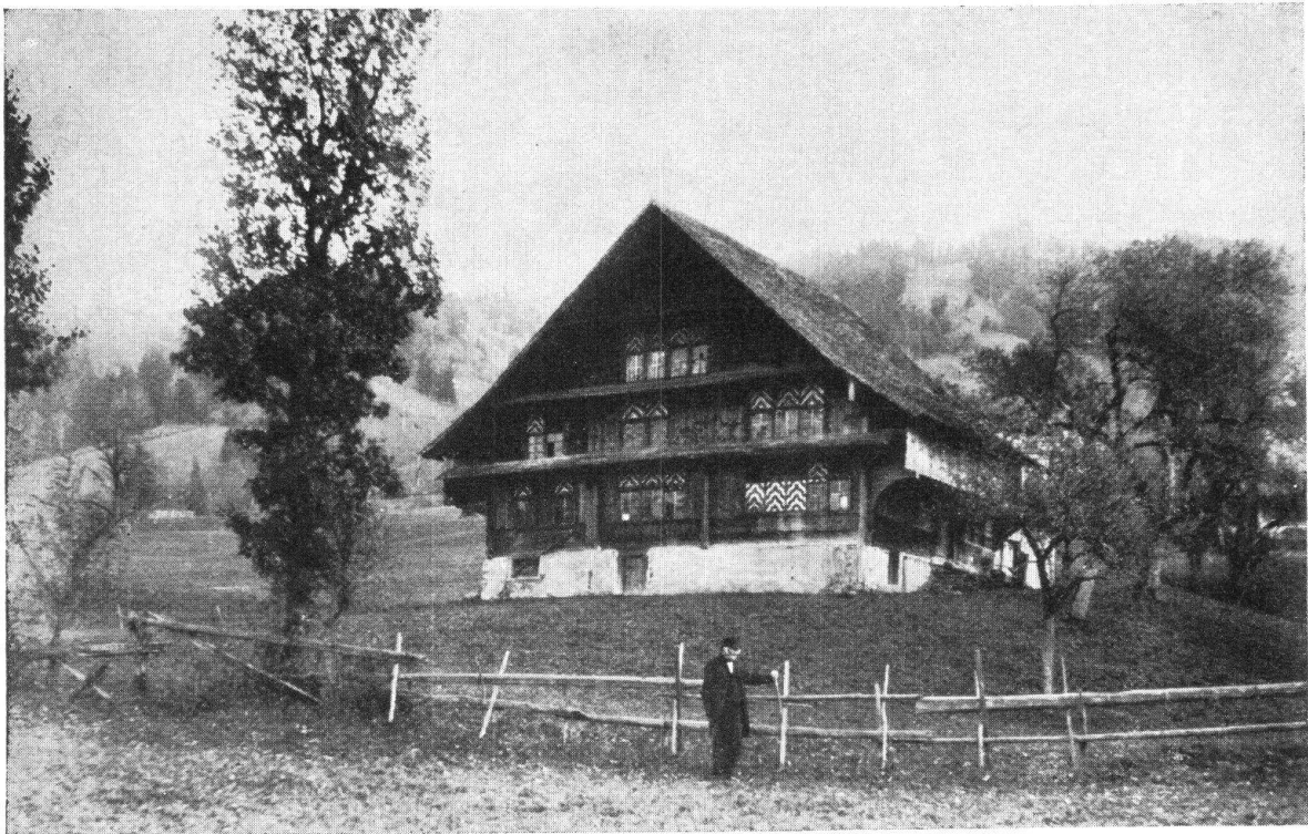
Abb. 4. Altes Bauernhaus in Schüpheim (Entlebuch). Kein Walmdach, dafür sind die Fensterreihen durch Klebdächer geschützt. Wenig Dachraum, weil die hochgelegene Gegend kaum noch Getreide hervorbringt. Charakteristisch ist der Bogen, der von der Front zur „Laube“ führt. (Nach einer Ansichtskarte vom 1. Luzerner Natur- und Heimatschutztag 1927). — Fig. 4. Ancienne maison paysanne à Schüpheim (Entlebuch). Toit à deux pans seulement; par contre les fenêtres sont protégées par des auvents. Peu d'espace libre sous le toit, car la culture des céréales est rare à cette altitude. Caractéristique est l'espèce de corniche arrondie qui prolonge la façade vers la galerie. (D'après une carte postale illustrée, éditée à l'occasion de la 1 re journée du Heimatschutz et du Naturschutz, à Lucerne, en 1927).
