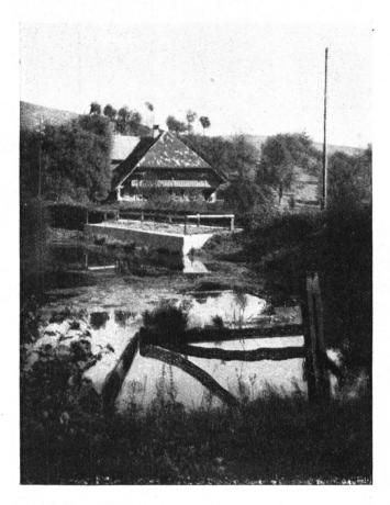
Abb. 11. Gegenbeispiel. Derselbe Weiher wie auf Abb. 10 im gegenwärtigen Zustande, verunstaltet durch einen aus Zementerrichteten Standplatz für die Feuerspritze, abseits der Entnahmestelle für das filtrierte Wasser. Der beabsichtigte Zweck hätle ohne Verunstaltung auf andere Weise besser und einfacher erreicht werden können. — Fig. 11. Mauvais exemple. Le même étang que sur la fig. 10, enlaidi par un accès cimenté pour la pompe.
