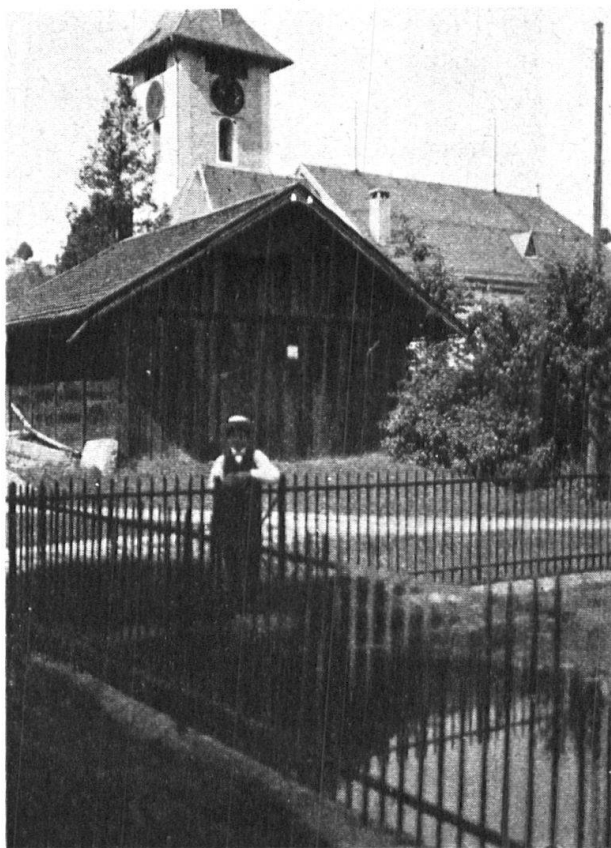
Abb. 5. Gegenbeispiel. Schlechter Feuerweiher in Eriswil, Kt. Bern. Der Feuerweiher mit den gefährlichen Eisenspiessen, das Spritzenhaus und die «modernisierte» Kirche mit Schieferbedachung und Blechkanteneinfassung wetteifern an Banalität miteinander. — Fig. 5. Mauvais exemple. Bassin cimenté à Eriswil, canton de Berne.
