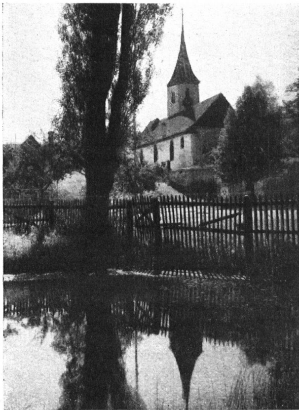
Abb. 4. Beispiel. Guter Feuerweiher in Oberbalm, Kanton Bern. Der Feuerweiher war ohne Zaun und diente alljährlich bei der Auf-führung von Schillers «Wilhelm Tell» durch die Dorfschüler als Vierwaldstättersee. Die Zementierung ist beabsichtigt; das schöne Dorfbild würde dadurch gänzlich zerstört. — Fig. 4. Bon exemple. Etang pittoresque à Oberbalm, canton de Berne.
