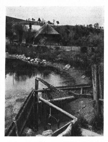
Abb. 10. Beispiel. Guter Feuerweiher in Burgistein, Kanton Bern. Im Vordergrund befindet sich eine durch verstellbaren Hebel zu regulierende Auslaufvorrichtung. Das Gifter aus Holzstäben hälf Pflanzen und Schlamm zurück. Schöne und zugleich zweckmässige Anlage. Phot. Albert Stumpf, Bern. — Fig. 10. Bon exemple. Etang à Burgistein. L'installation au premier plan permet d'avoir de l'eau filtrée dans la partie close de l'étang où se trouve l'écoulement réglable.
