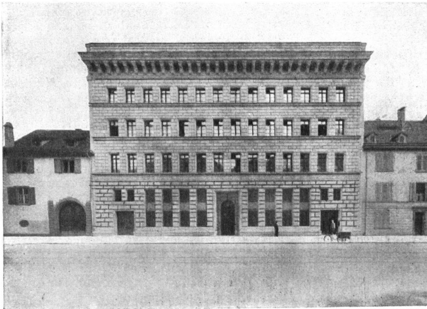
Abb. 15. Der Neubau der Nationalbank am St. Albangraben in Basel. Durch seine Höhe und Massigkeit gewiss einträglich und die Wünsche des Bauherrn erfüllend, aber in diesem alten Stück Stadtbild fremd, ja explosiv wirkend. Photo B. Wolf, Basel. — Fig. 15. Le nouveau bâtiment de la Banque Nationale à la rue des Fossés Saint-Alban à Bâle. Construction de rapport, il est vrai, grâce à sa hauteur inaccoutumée, et qui doit satisfaire les exigences du propriétaire, mais qui apporte une note disparate dans ce quartier.
