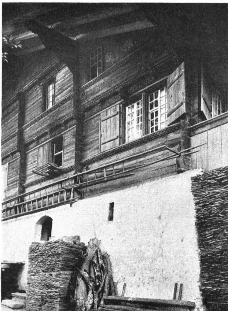
Abb. 3. Von einem Chalet in Bönigen. Durch die ausgekragten Stockwerke und vorstehenden Hauptbalken mit markanten Schnitzereien wirkt die Fassade sehr plastisch. — Fig. 3. Détail d'un chalet à Bönigen. Grâce aux poutres principales en saillie et ornées de sculptures, la façade est d'un bel effet plastique.
