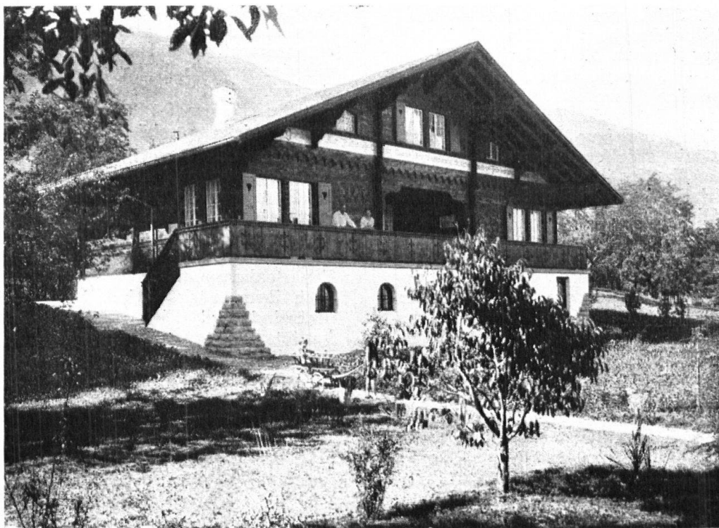
Abb. 14. Chalet Dr. Weber, Leissigen. Arch. Urfer & Stähli, Interlaken. Seeseite; gute Verhältnisse von Mauer und Holzwand. Durchgehende Laube, in der Mitte als Sitzplatz in das Haus hineingebaut. — Fig. 14. Chalet de M. le Dr. Weber à Leissigen, Urfer et Stähli, architectes à Interlaken. Façade tournée vers le lac. Bonnes proportions de la maçonnerie et des étages en bois. Galerie courant autour de la maison avec, dans la façade, place en retrait servant de véranda.
