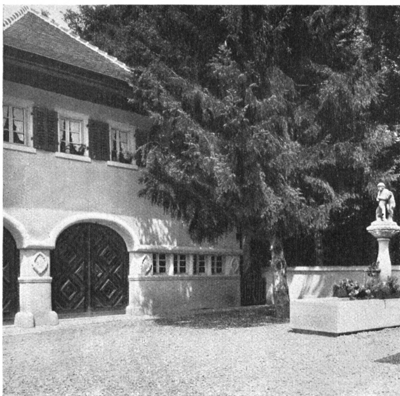
Abb. 9. Garage Arthur Frölich in Bergdietikon. Technischer Bau mit Wohnung verbunden. Gute Türen. Architekt Albert Frölich, Zürich. — Fig. 9. Garage Arthur Frölich à Bergdietikon. Bâtiment d'exploitation industrielle, avec appartement. Portes d'un beau modèle. Albert Frölich, architecte, Zurich.
