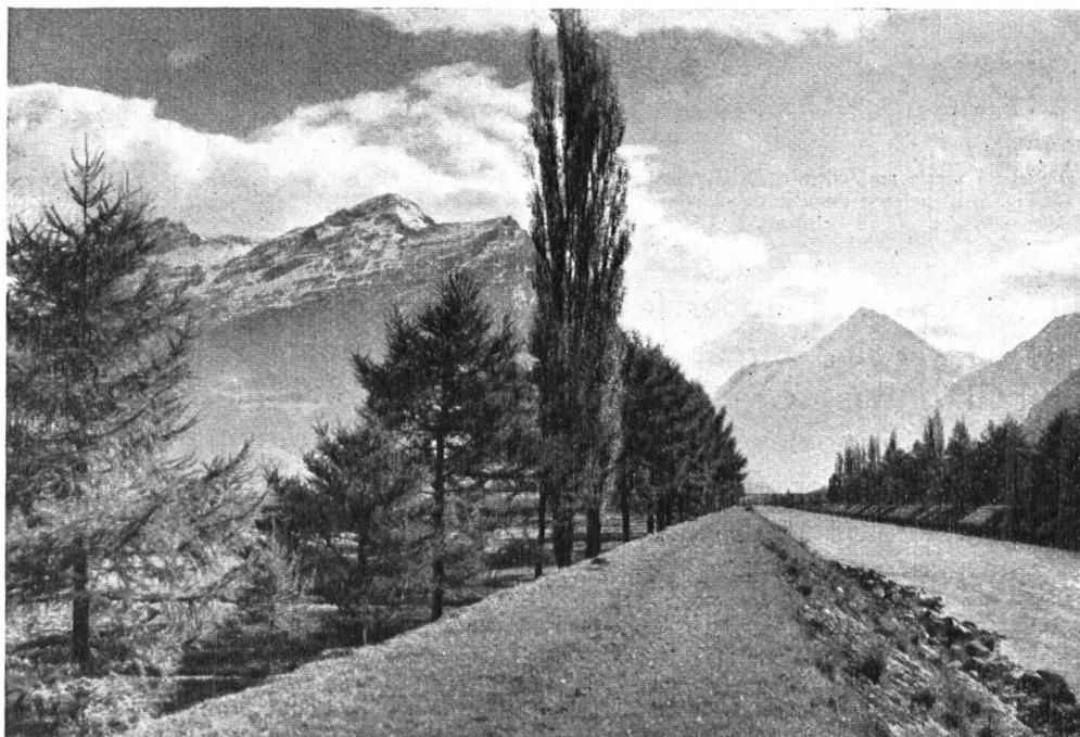
Abb. 4. Der Reusskanal. Erfreulicherweise beleben Pflanzungen von Lärchen und Pappeln die sonst einformigen Ufer. Aufnahme von M. Aschwanden, Flüelen. — Fig. 4. Le canal de la Reuss. Des plantations de mélèzes et de peupliers animent heureusement ces rives uniformes. Cliché de M. Aschwanden, Flüelen.
