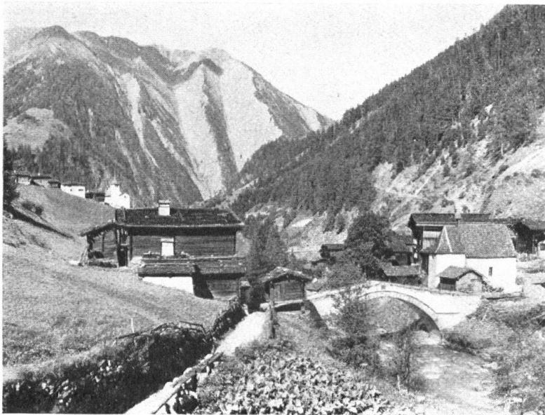
Fig. 6. Pont de Binn. (Photo Wehrli S. A., Kilchberg-Zurich). Ce paysage, où les horizontales sont rares et heureusement courtes, la ligne brisée du parapet est agréable. Dans cette vallée reculée, ce monument s'offrira encore longtemps à l'admiration des générations. — Abb. 6. Brücke zu Binn. (Photo Wehrli A. G., Kilchberg bei Zürich). In dieser Landschaft, wo die horizontale Linie sich nur selten findet, wirkt die gebrochene Wölbung des Brückenbogens angenehm. Das alte Baudenkmal wird in diesem entlegenen Tale wohl noch lange erhalten bleiben.
