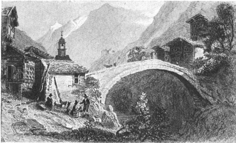
Fig. 3. Pont de Stalden, d'après une ancienne gravure (collection Curiger). Cette arche, plus ample que le lit du torrent, ce parapet qui s'incurve, semblent marquer l'effort à maintenir les rives escarpées. Le «Neubücke» est actuellement abandonné. — Fig. 3. Brücke zu Stalden, nach altem Stahlstich (Sammlung Curiger). Dieses hoch gewölbte Brückenjoch, weiter gespannt als das Flussbett, scheint die auseinanderstrebenden Ufer vereinen zu wollen. Die „Neubücke“ wird gegenwärtig nicht mehr benutzt.
