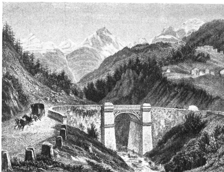
Fig. 5. Le pont de la Ganther sur la route du Simplon, d'après une gravure (collection Curiger). On peut lui reprocher une disproportion entre les lourdes culées et le léger pont de bois, ainsi qu'une recherche de « style ». — Abb. 6. Die Ganther-Brücke an der Simplonstrasse, nach einem Stich (Sammlung Curiger). Das Verhältnis zwischen der leichten Holzbrücke und den schweren Pfeilern ist nicht ganz glücklich, auch wirkt die künstlerische Gestaltung zu wenig einheitlich, zu absichtlich.
