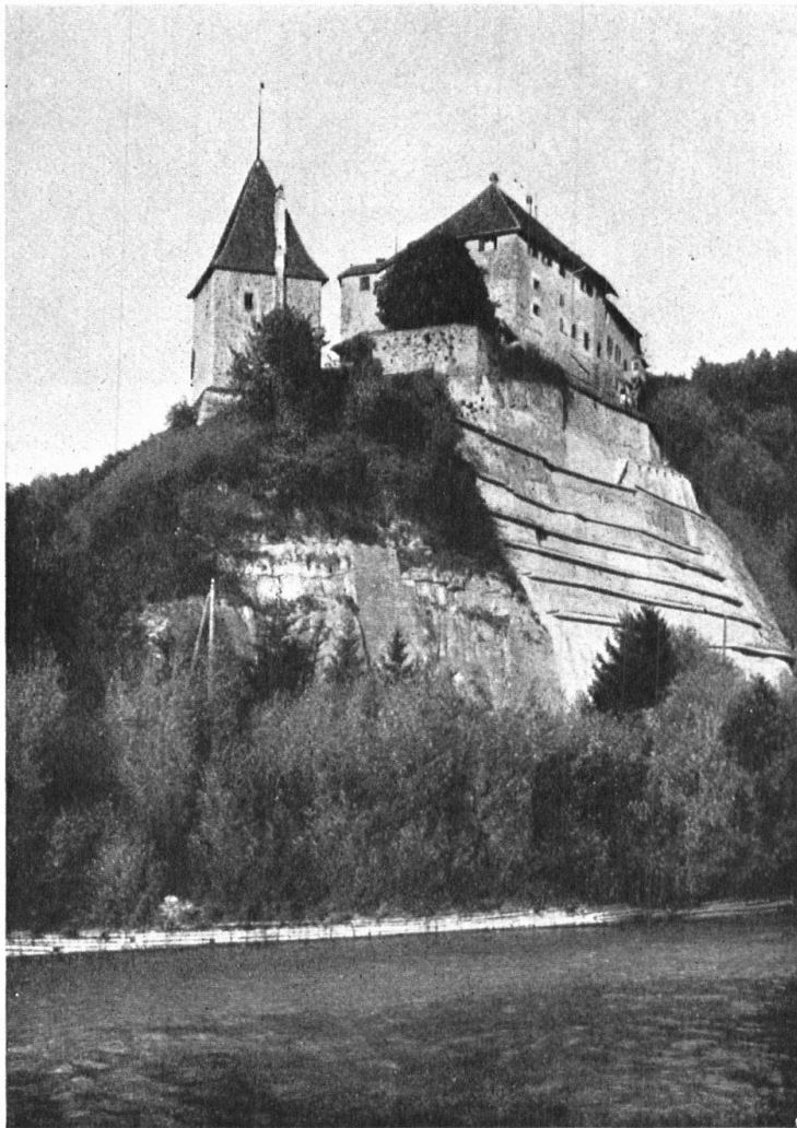
Abb. 12. Schloss Laupen von Süden. 1923. Links der, von der Zementierung noch nicht erreichte, Teil des Molassefelsens mit seiner natürlichen Vegetation. Hoffentlich ist es möglich, diese Partie noch weiter zu schonen. Aufnahme von H. Weber, Zürich. — Fig. 12. Le château de Laupen, vu du sud. A gauche les falaises de molasse, non encore attaquées par les travaux de consolidation. Belle végétation naturelle. Espérons qu'il sera possible de la ménager. Cliché de Mr. H. Weber, Zurich.
