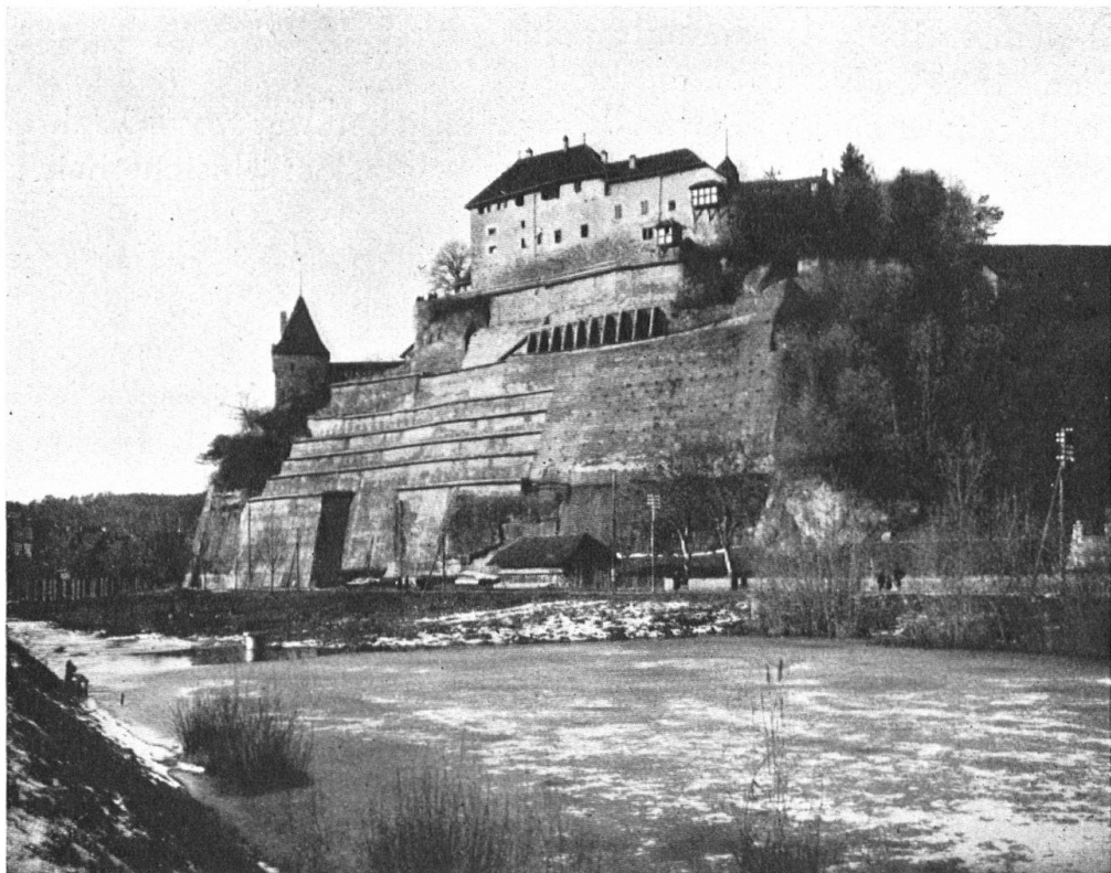
Abb. 11. Der Schlossfelsen nach vorläufiger Beendigung der Stützbauten. Der jüngere Teil zeigt Terrassen, die sich dem Felsen anschmiegen; gelingt die Bepflanzung, so mag dann diese Partie besser aussehen als der Zementblock rechts. Aufnahme von H. Weber, Zürich. — Les falaises du château. Etat actuel et provisoire des travaux de consolidation. Dans la partie la plus récente, au fond, on distingue des terrasses qui s'adaptent aux formes du rocher. Si l'on réussit à y faire croître de la végétation, elle produiront peut-être un effet moins laid que les énormes blocs de ciment de droite. Cliché de M. H. Weber, Zurich.
