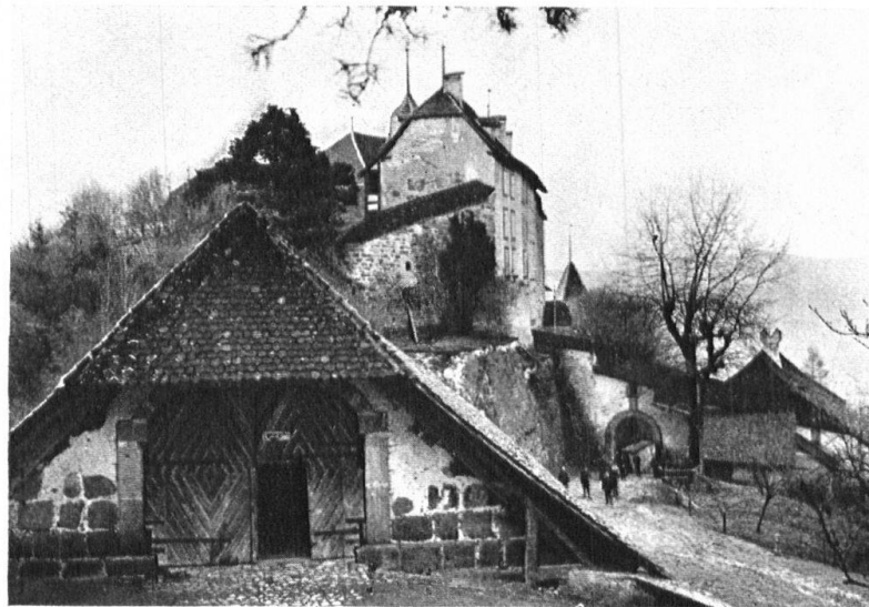
Abb. 9. Rückansicht des Schlosses; vorn die Scheune, rechts Berntor und Stadtmauer. Fig. 9. Le château vu de derrière; au premier plan la grange, à droite la porte de Berne et les murs d'enceinte de la ville.
