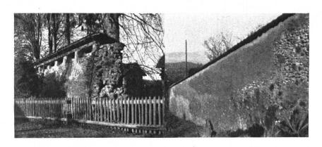
Abb. 13. Zwei Ueberreste der Stadtmauer, des Wehrganges beraubt und mit einem blossen Schutzdache bedeckt. Stumme Anklagen gegen die verständnislose Zeit des Demolierens, Fig. 13. Deux restes des murailles d'enceinte de la ville; on a démoli la galerie de ronde. mais on a recouvert les murs d'un toit protecteur. Eloquente condamnation de l'époque ou l'on détruisait tous les souvenirs du passé.
