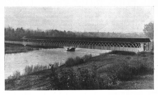
Abb. 9. Alte Thurbrücke in Rohr bei Frauenfeld; Typus der gedeckten Holzbrücke. — Fig. 9. L'ancien pont de la Thur à Rohr, près Frauenfeld. Type de l'ancien pont couvert en bois.
