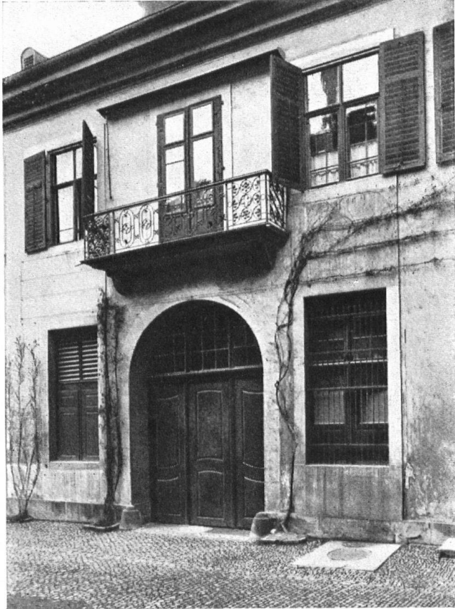
Abb. 3. Detail aus dem Hofe — Fig. 3. Détail de la cour.
