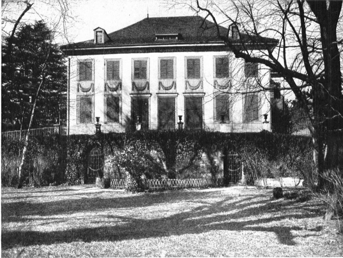
Abb. 2. Gartenfront im Morg-nlicht, bei geschlossenen Fensterläden. Links oben die Zeder. Vorfrühling 1924. Zu beachten, dass an den Fenstern die Gesimse fehlen; auch auf die geschmackvollen Kellertore unter der Terrasse sei verwiesen. Fig. 2. La façade principale du château Werdmüller donnant sur les jardins. Tous les volets clos. A gauche, en haut, le vieux cèdre. Remarquer que les fenêtres n'ont pas d'appuis et que les portes des caves sont particulièrement décoratives.
