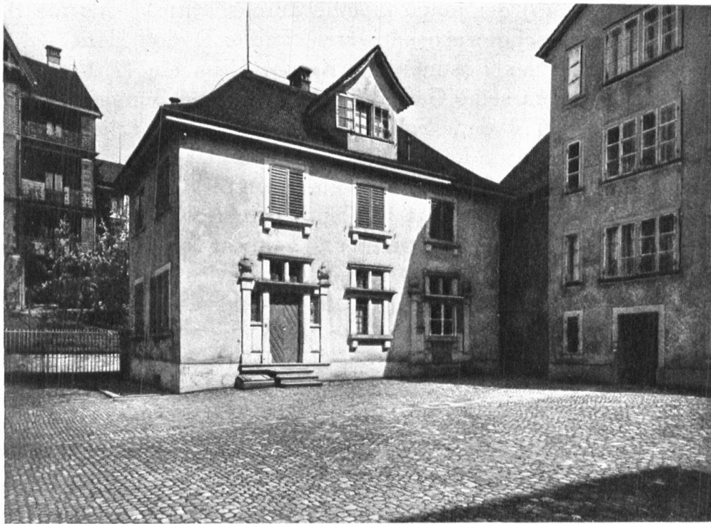
Abb. 7. Das frühere (kleine) Herrschaftshaus, von Junker Hartmann Grebel an der Beckenhofstrasse erstellt. Fassade gegen Westen und Hof (Hauptfassade). — Fig. 7. L'ancienne (petite) maison de maîtres du noble Hartmann Grebel, sur la Beckenhofstrasse, cour et façade principale, donnant sur l'ouest.
