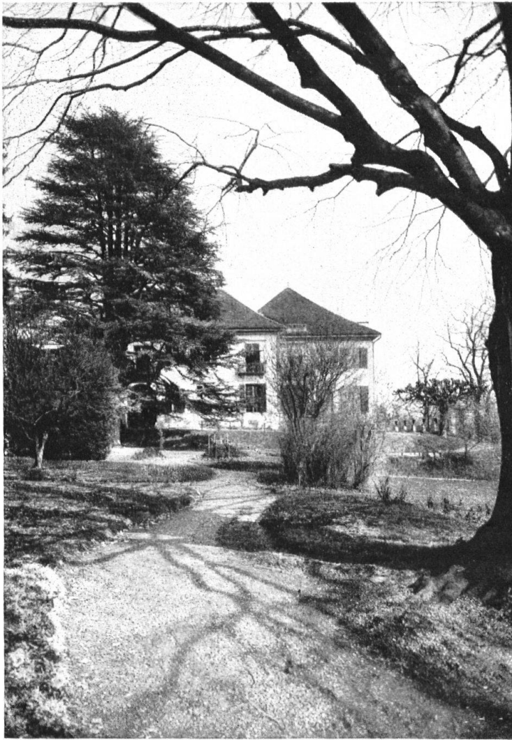
Abb. 1. Die südlichen Seitenfronten des Werdmüllerhauses in Zürich, vom Park aus gesehen. Vorfrühling 1924. — Fig. 1. Les façades méridionales du château Werdmüller à Zurich, vues du parc. Cliché pris en printemps, 1924.
