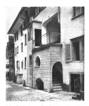
Abb. 8. Portalvorbau zur "Glocke". Leider mit Zement überkleistert und als Stein-Quaderbau auffrisiert. — Fig. 8. Le même portail rafistolé, recouvert de ciment imitant la pierre de taille.
