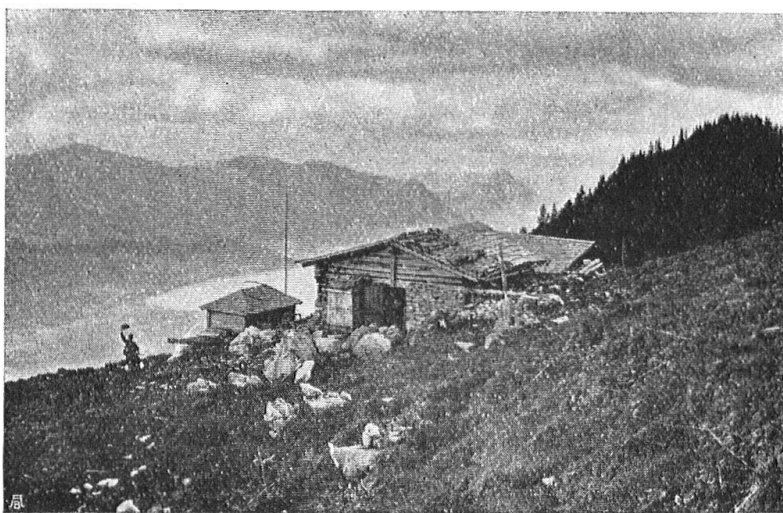
Abb. 3. Alphütte auf Stanserhorn. Schindelschwerdach und Schindelnageldach. — Fig. 3. Chalet sur une alpe du Stanserhorn. Toit de bardeaux, en partie cloués, en partie consolidés par des pierres.
