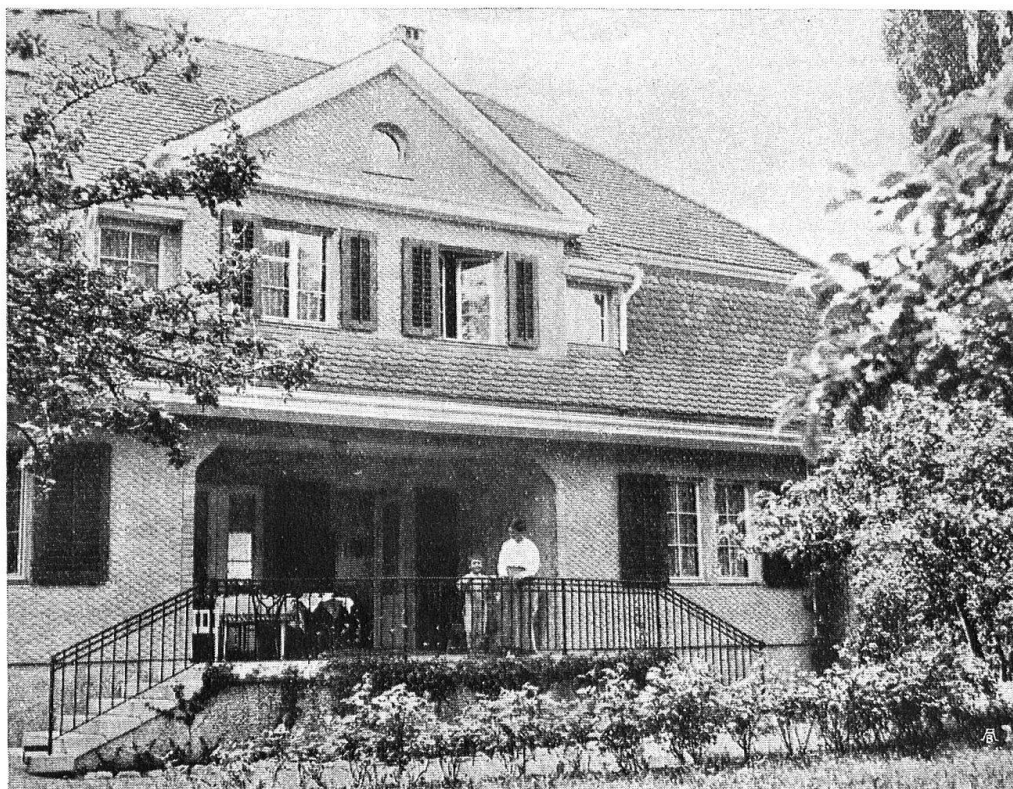
Abb. 25. Villa. Architekten Streiff & Schindler, Zürich. Äussere Wandverkleidung: Eternit in Wabendeckung; Dach: Bieberschwanz-Ziegel. — Fig. 25. Villa Streiff & Schindler, architectes, Zürich. Revêtement extérieur des murailles en éternite. Toit de tuiles.
